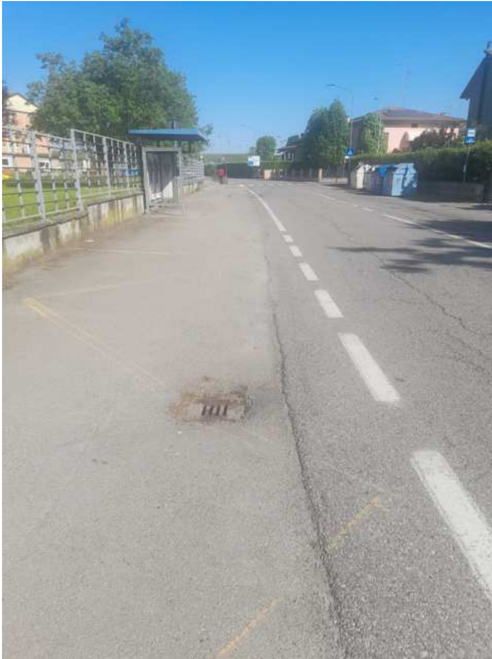
Via Moro lato Ovest
