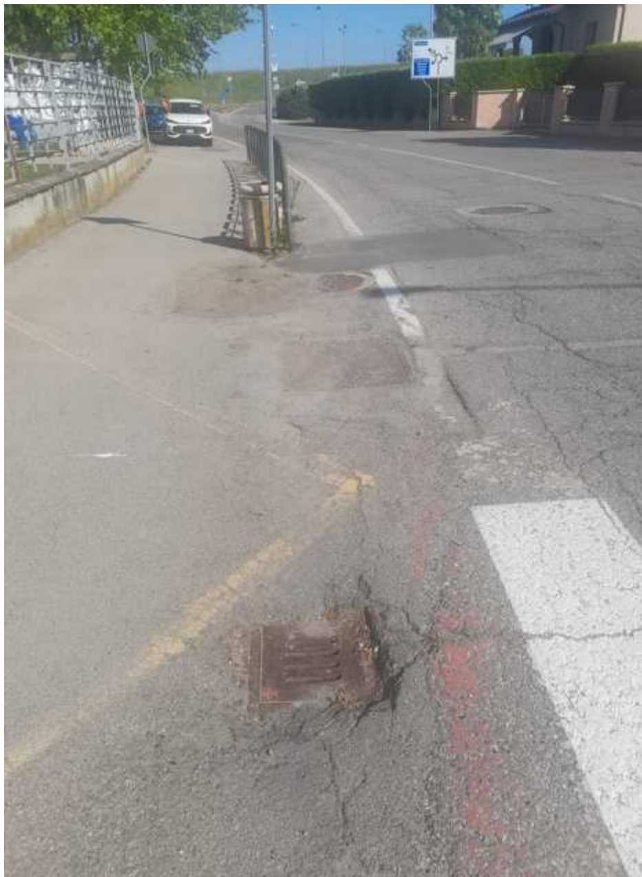
Via Moro lato Ovest Particolare attraversamento e caditoia
