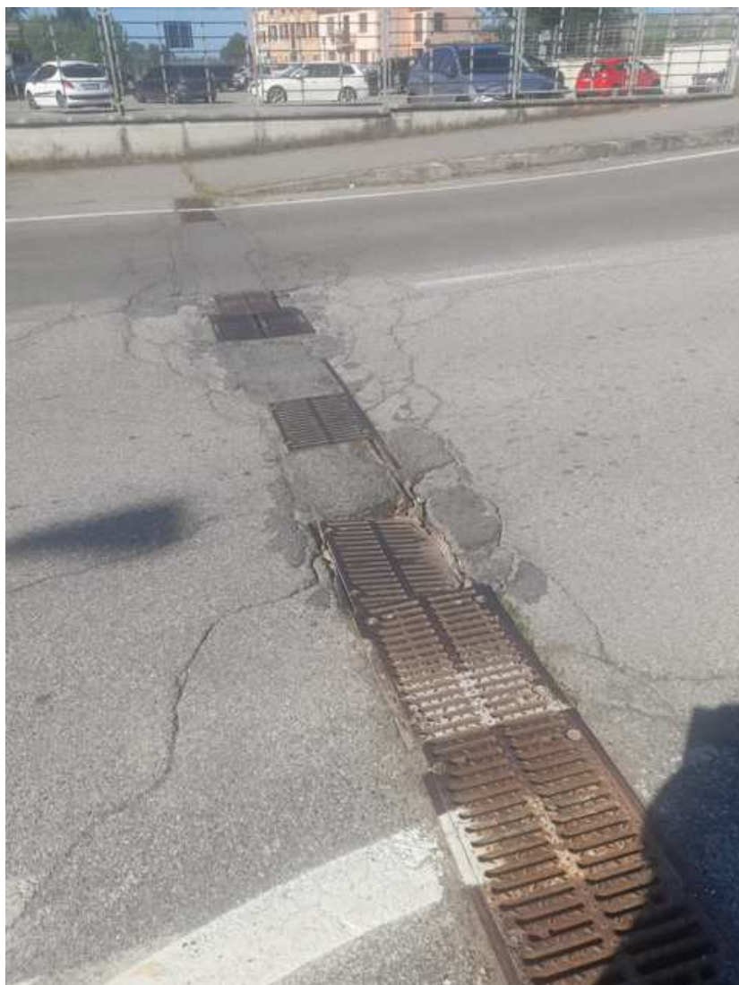
Canaletta scolo acque Rotatoria lato nord
