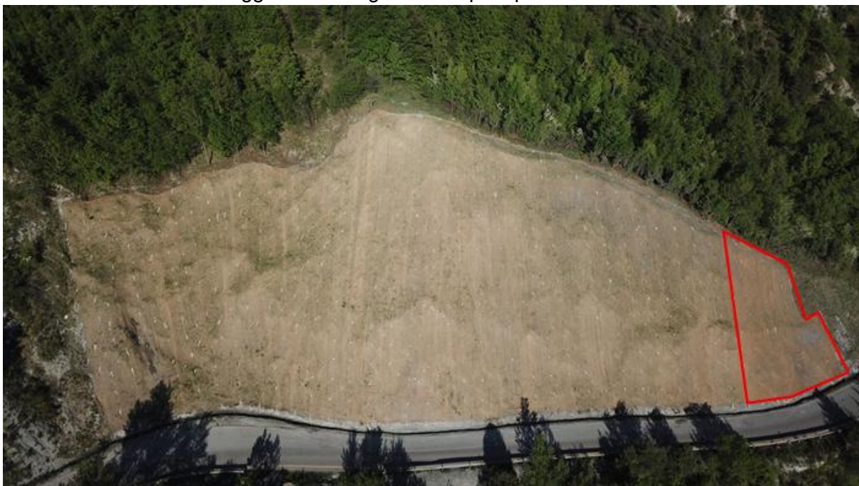
Vista aerea delle superfici oggetto di rinforzo (in rosso superficie integrativa)
