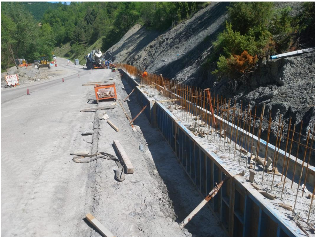
Andamento del muro con spezzata ad unica concavità
