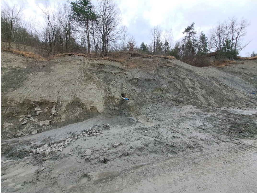
Continue venute d'acqua e colate di fango alla base del pendio
