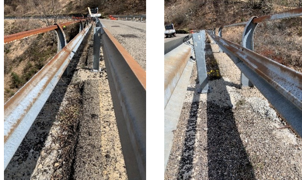
Fig. 3.2.6 - SP 15 - Barriere di sicurezza
