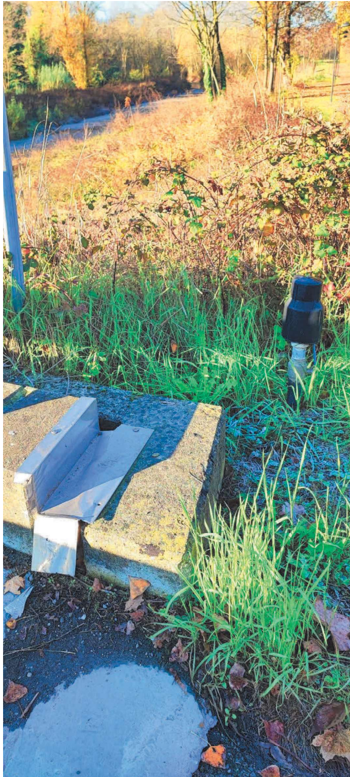
Foto 16 – Sostituzione della lamiera di copertura del giunto lato Scandiano.
