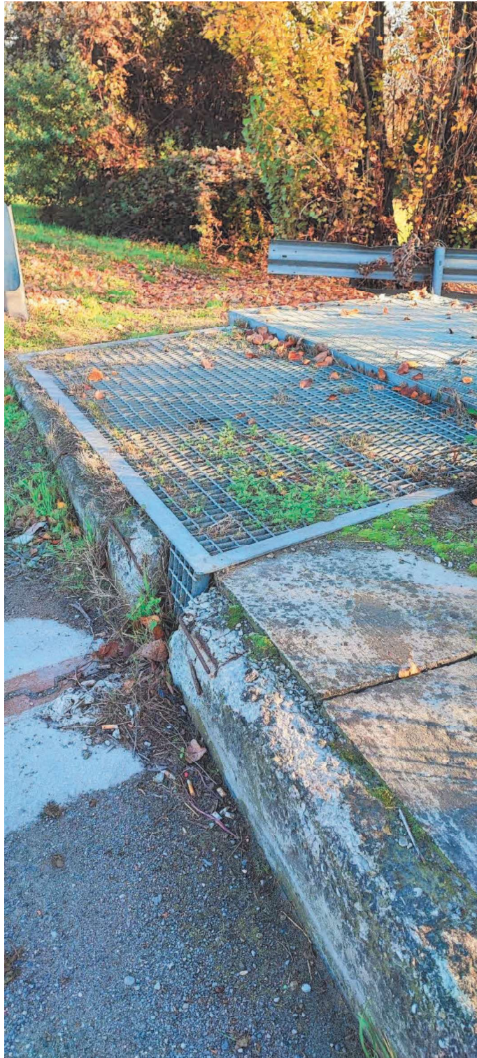
Foto 10 – Pulizia delle griglie di accesso alle tubazioni idriche. Le fessure di dimensioni eccessive verranno chiuse tramite malta elastica.
