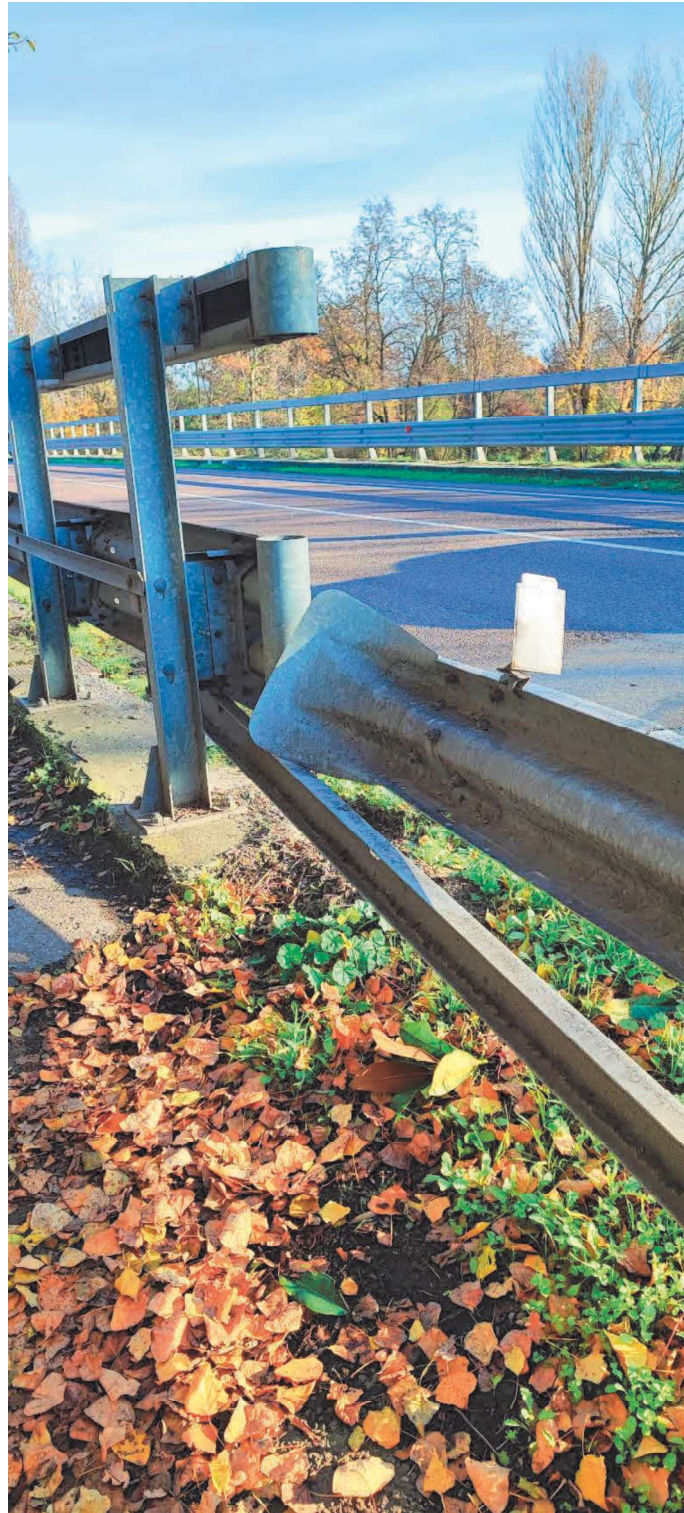
Foto 13 – Installazione di un profilo di supporto guard-rail aggiuntivo.
