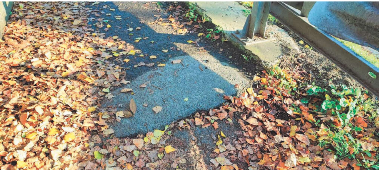
Foto 9 – Eliminazione del dislivello della pista ciclabile tramite riprofilazione dello strato di usura.
