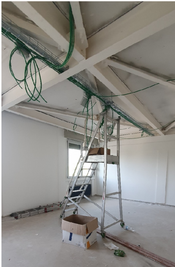
PRESA FOTOGRAFICA N.1 – Rifacimento impianti elettrici
