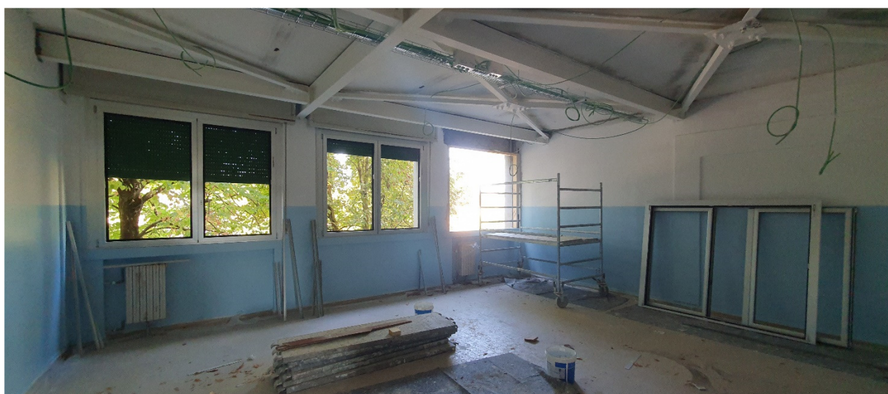
PRESA FOTOGRAFICA N.2 – Montaggio nuovi serramenti in alluminio e tinteggiatura a smalto
