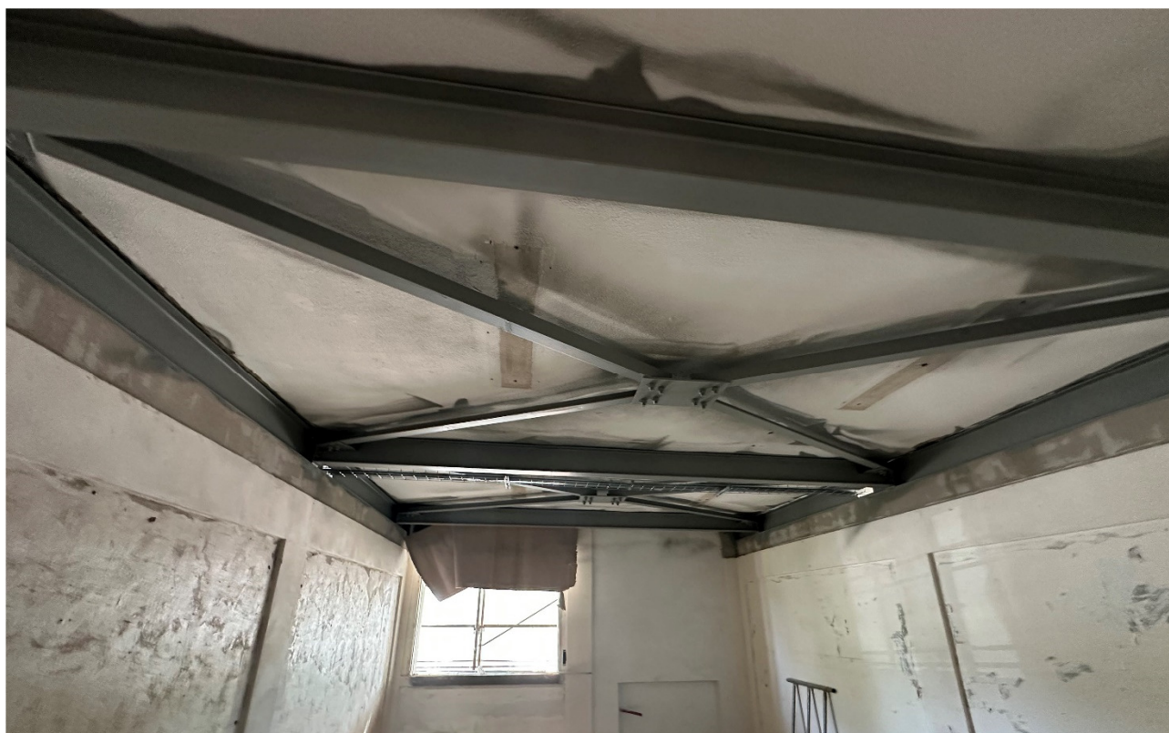
PRESA FOTOGRAFICA N. 4 – Carpenteria metallica
