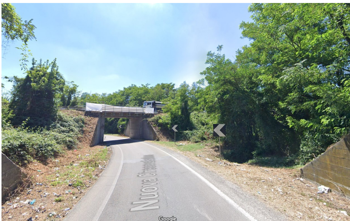
Stato attuale (rampa Sassuolo-Castellarano direzione Castellarano - secondo cavalcavia)
