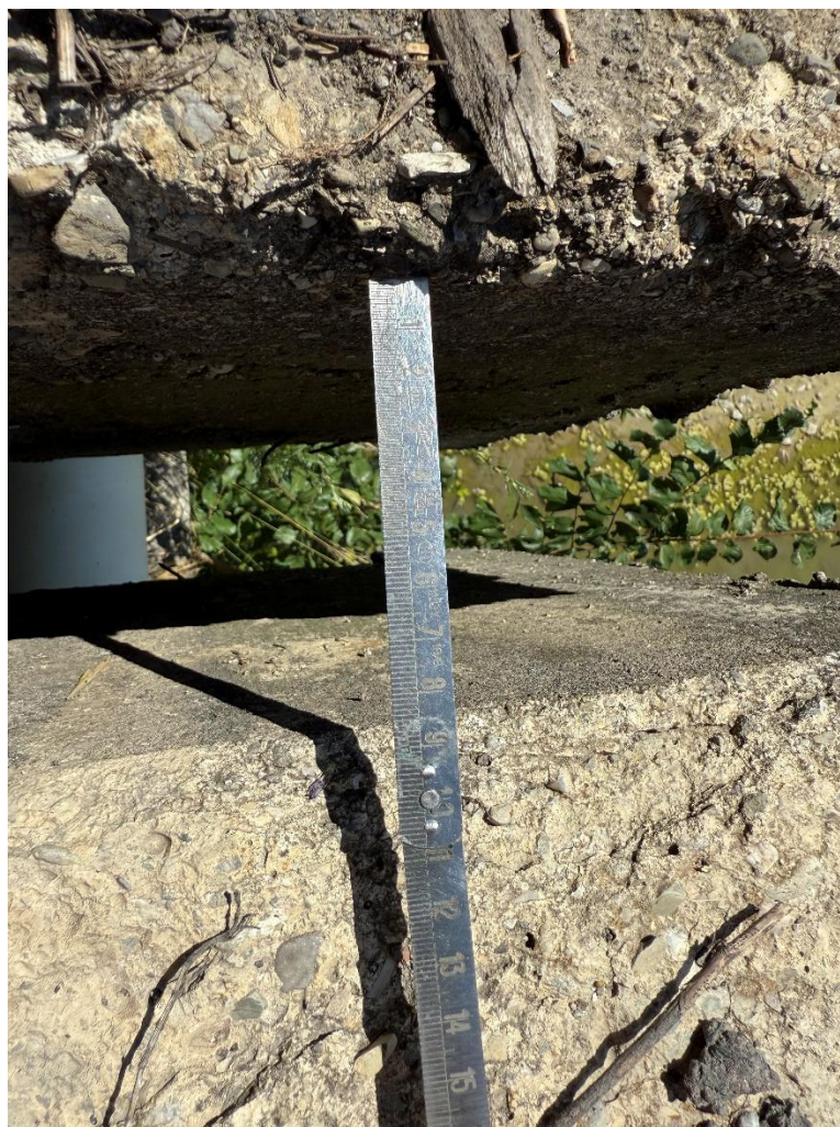
Figura – Rilievo varco giunto
