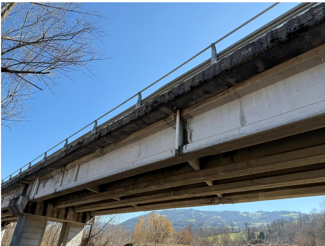
2.1 Foto del ponte
