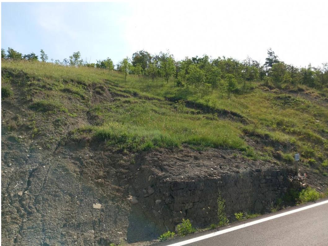
**Foto 8 - Vista della gabbionata centrale esistente con principio di nuovo movimento franoso nel versante nel tratto stradale lato Canossa, a maggio 2025**
