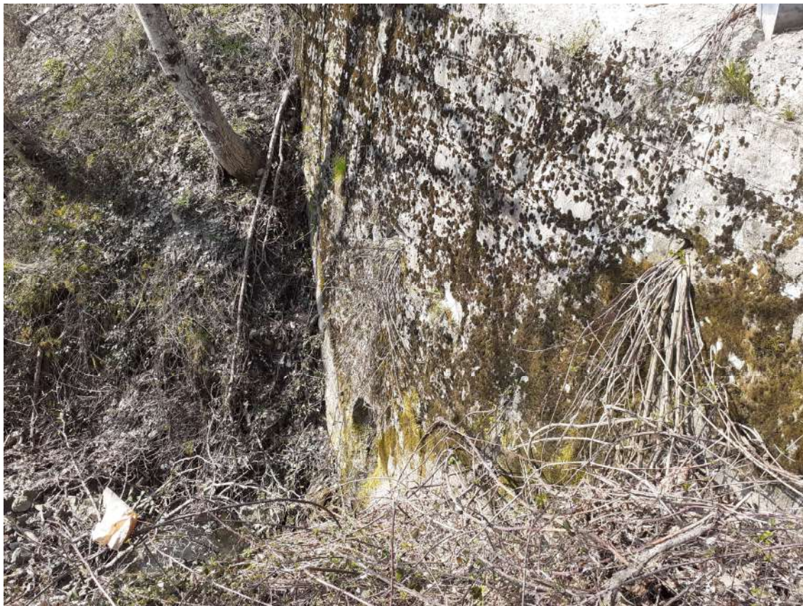
Foto 12 – vista del muro in sasso lato valle
