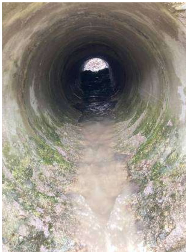
Foto 11 - Vista interna dell'attraversamento idraulico da monte a valle
