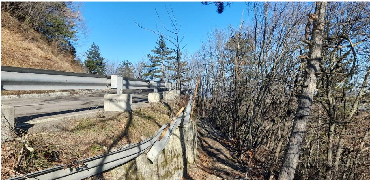
Foto 1 – Vista del muro di sostegno, della vecchia barriera stradale e del sistema di ritenuta posizionato provvisoriamente.
