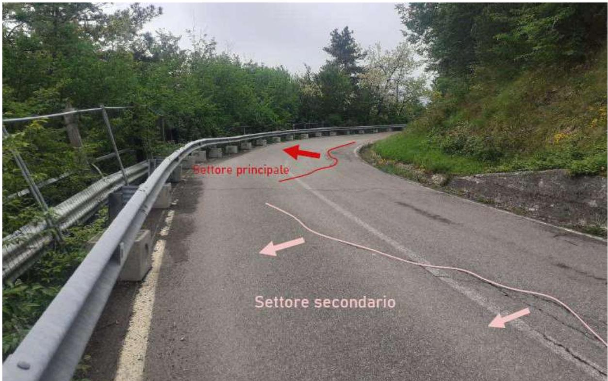
Foto 4 – Vista da nord del piano viabile, con evidenziate le fessurazioni causate dall’abbassamento dell’opera di sostegno esistente, si nota la vecchia barriera stradale piegata verso valle.
