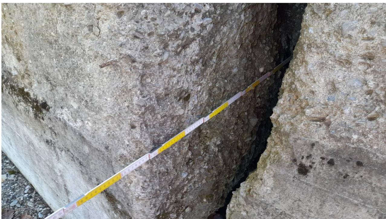
Foto 2 – Particolare di una delle rotture presenti principalmente nel tratto centrale del muro in calcestruzzo.
