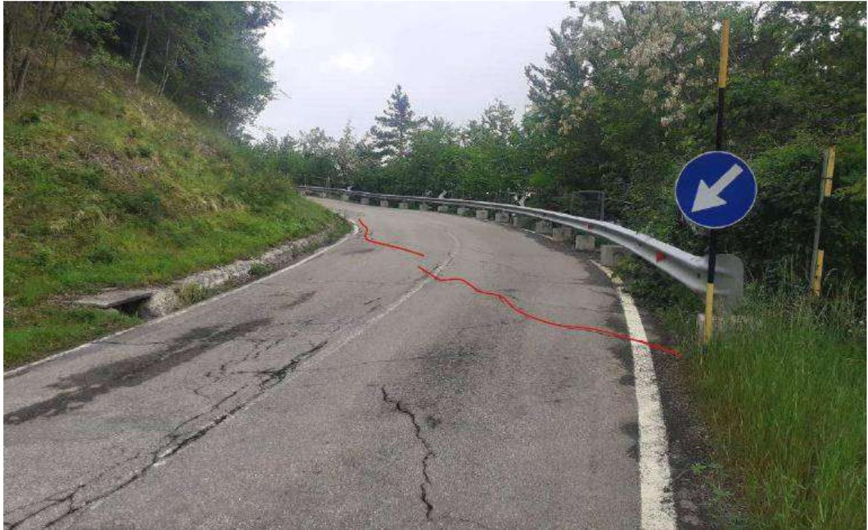
Foto 3 – Vista da sud del piano viabile, con evidenziate le fessurazioni causate dall’abbassamento dell’opera di sostegno esistente.
