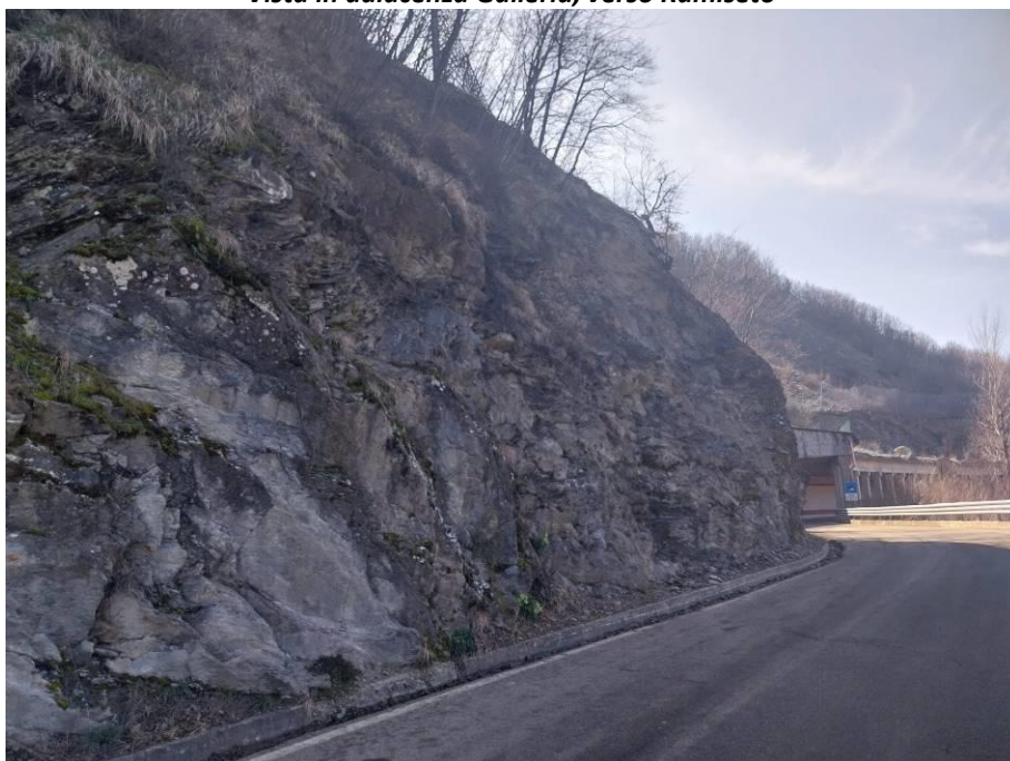
Vista lato Ovest in adiacenza Galleria, verso Miscoso
