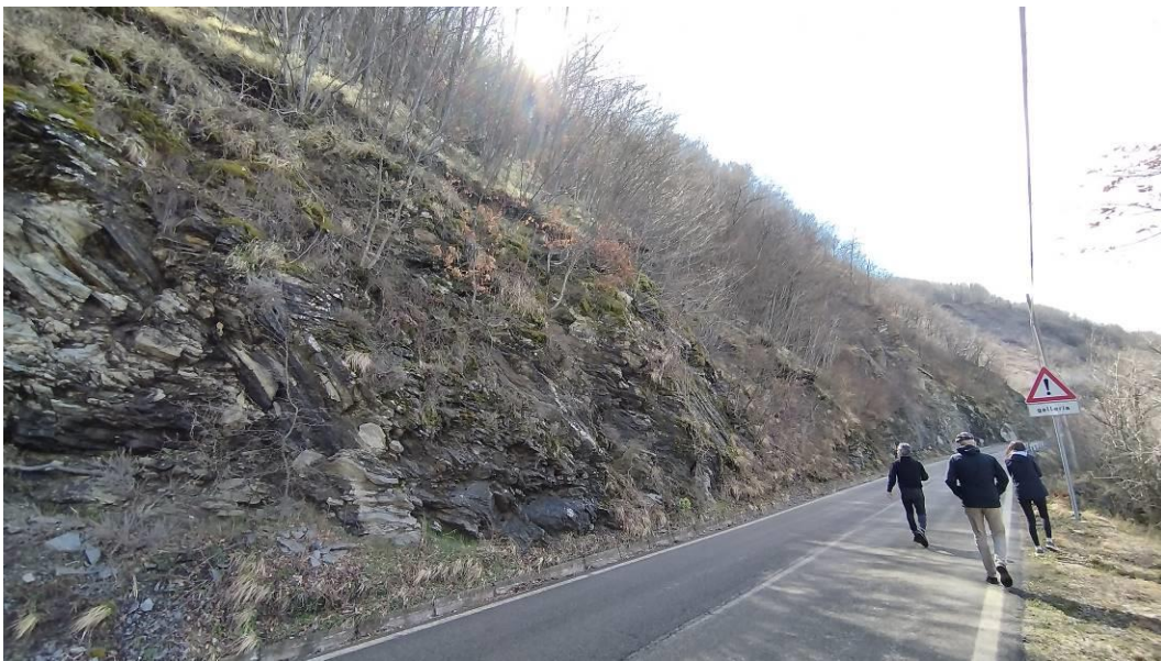
Vista lato Est, verso Miscoso
