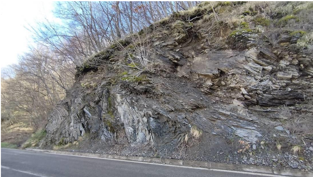
Vista lato Est
