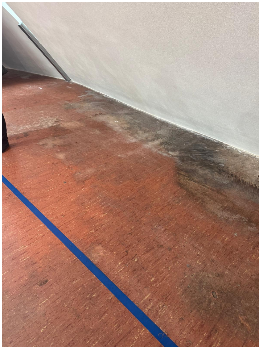
Figura 4 – Linoleum danneggiato
