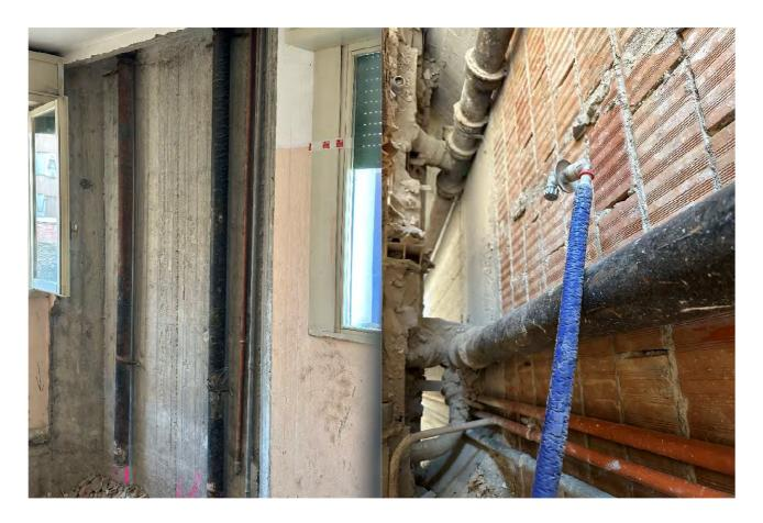
PRESA FOTOGRAFICA N.9 E N.10 TUBI DI SCARICO INTERFERENTI CON I SETTI DA REALIZZARE
