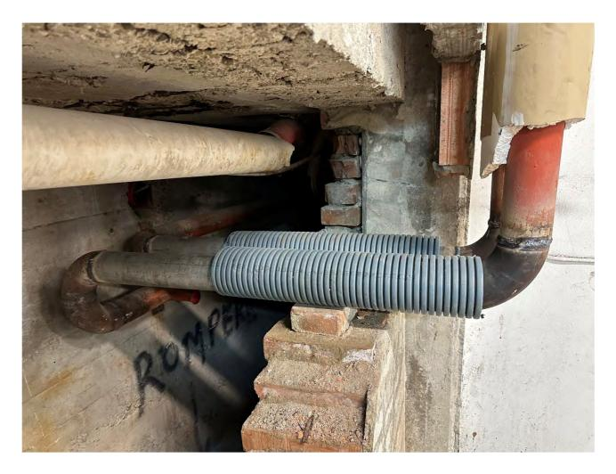
PRESA FOTOGRAFICA N.11 SOSTITUZIONE TUBAZIONI RISCALDAMENTO AMMALORATE
