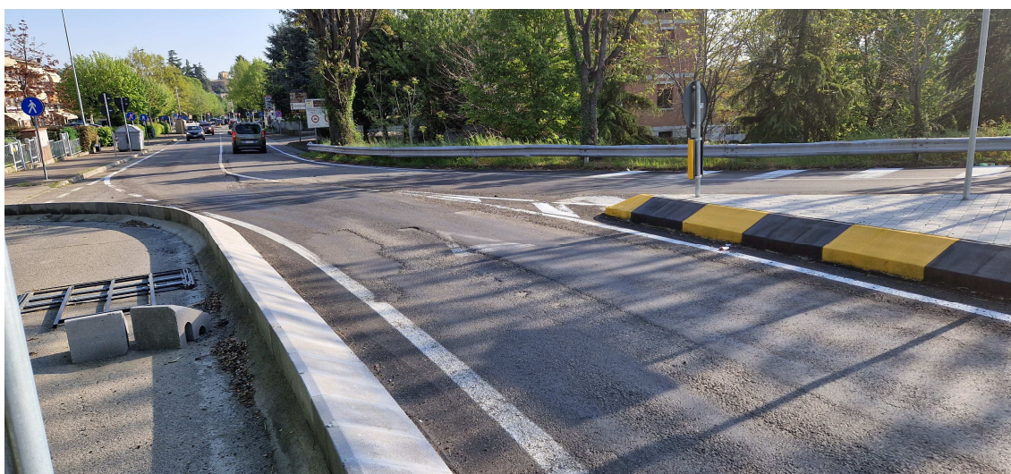
VISTA DELL' INTERNO DI VIA RADICI SUD
