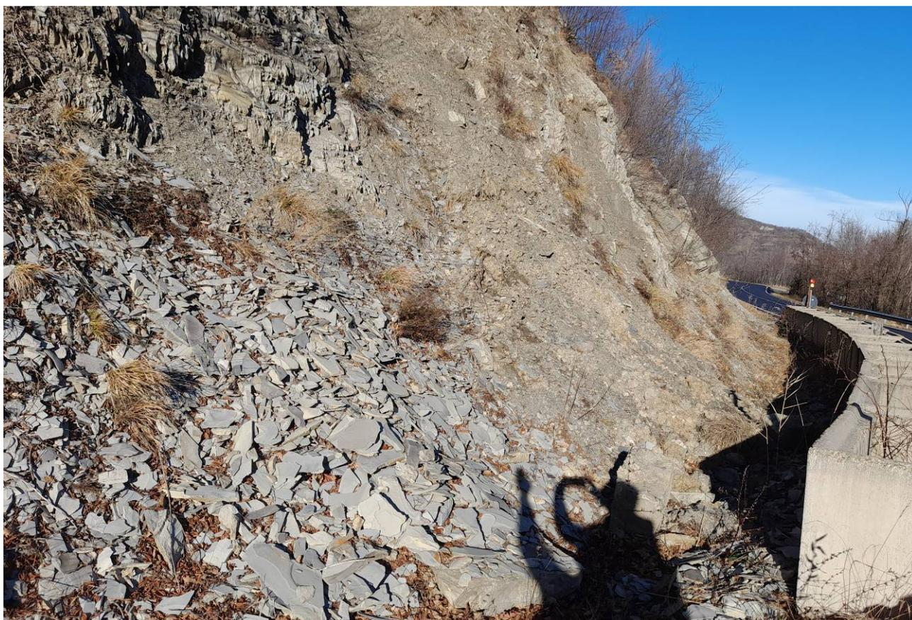
**Foto 3 – Vista del materiale lapideo distaccatosi dal versante ed accumulato alla base del pendio dietro ai cassoni in cemento.**
