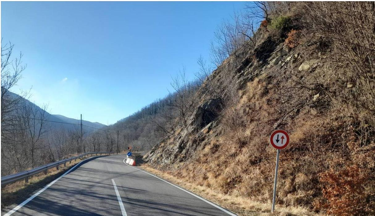
Foto 2 – Vista del versante lato Villa Minozzo, si vede la segnaletica di senso unico alternato e la posizione dei cassoni in cemento a protezione della sede stradale.
