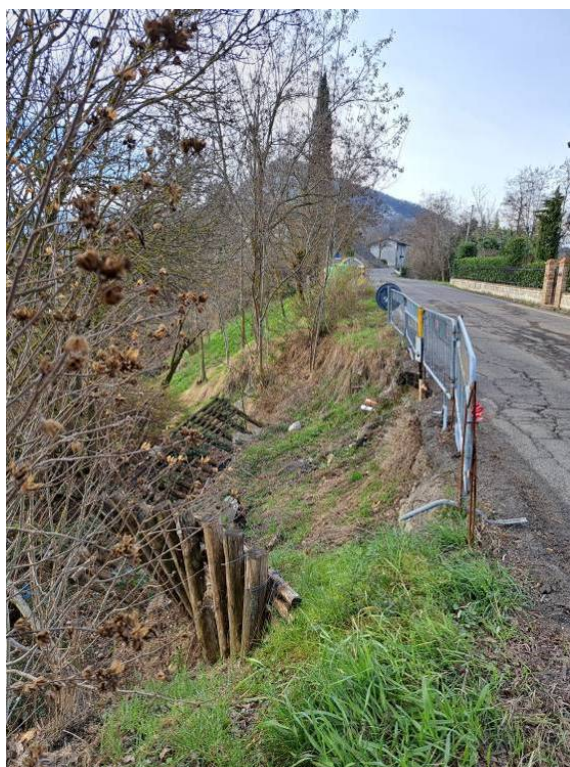
Foto 1 – Vista da est e da ovest del dissesto della scarpata di valle lungo il ciglio della strada provinciale.
