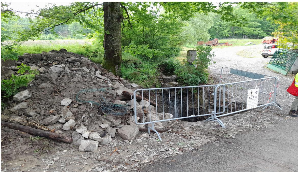
Foto 2 – Vista del punto in cui si è verificata l'ostruzione dell'attraversamento stradale con a lato il materiale proveniente dal fosso di scolo acque pubbliche
