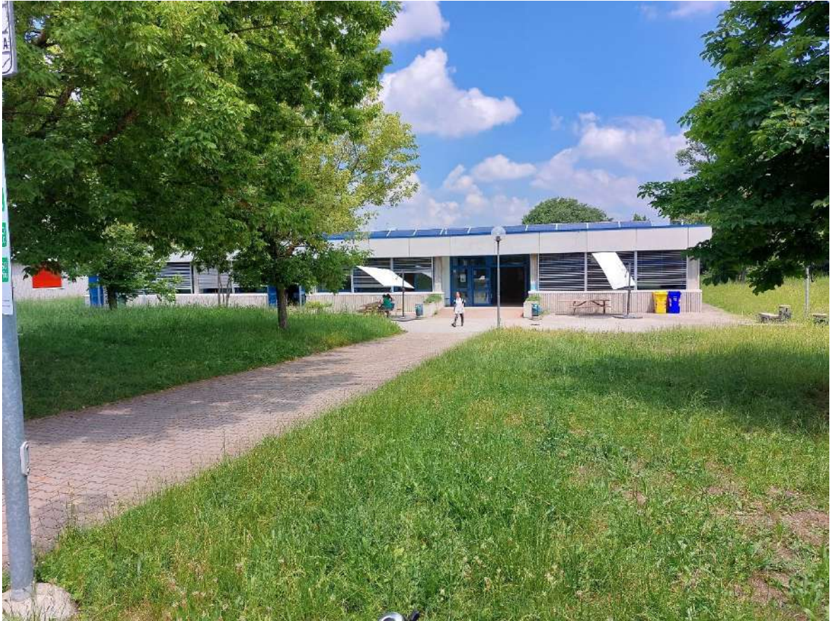
Lato SUD – U.S.3
