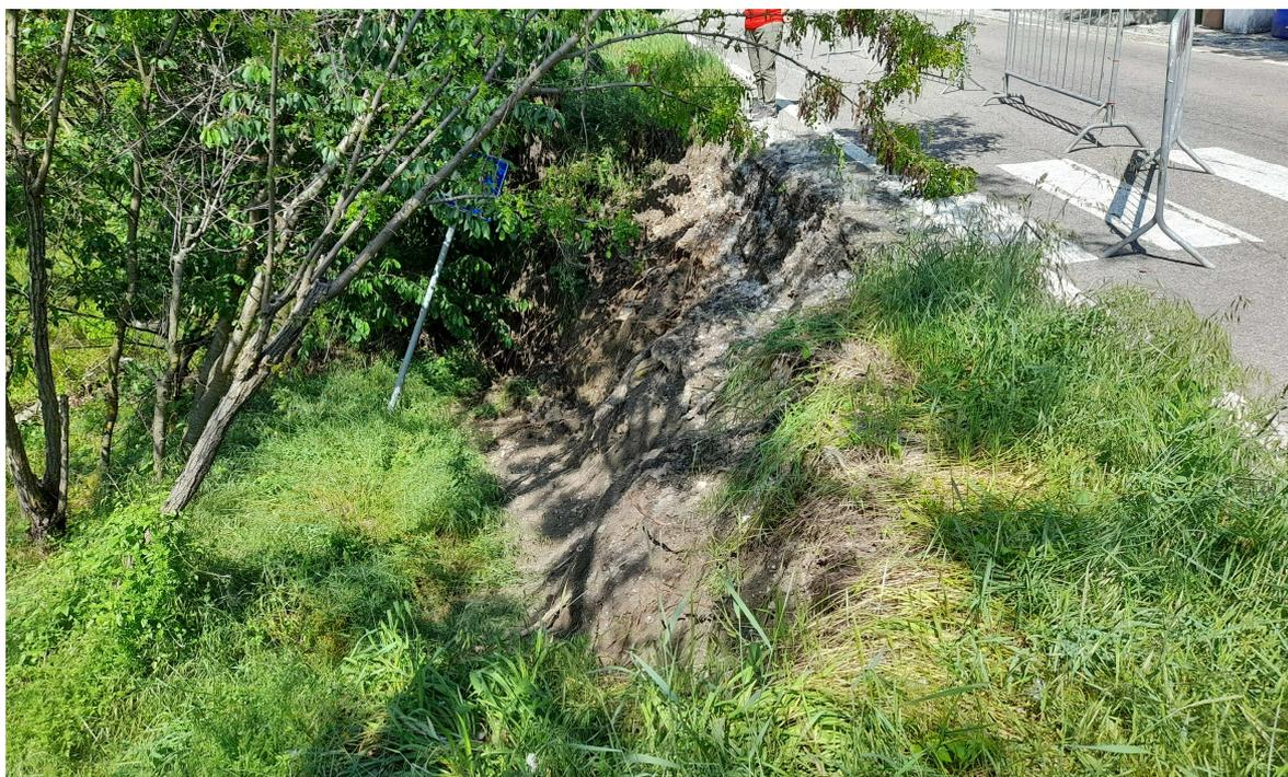
**Foto 4 - Vista del dissesto che interessa la scarpata di valle, dove verrà ripristinata la scarpata di valle e la banchina stradale (area di intervento 2).**
