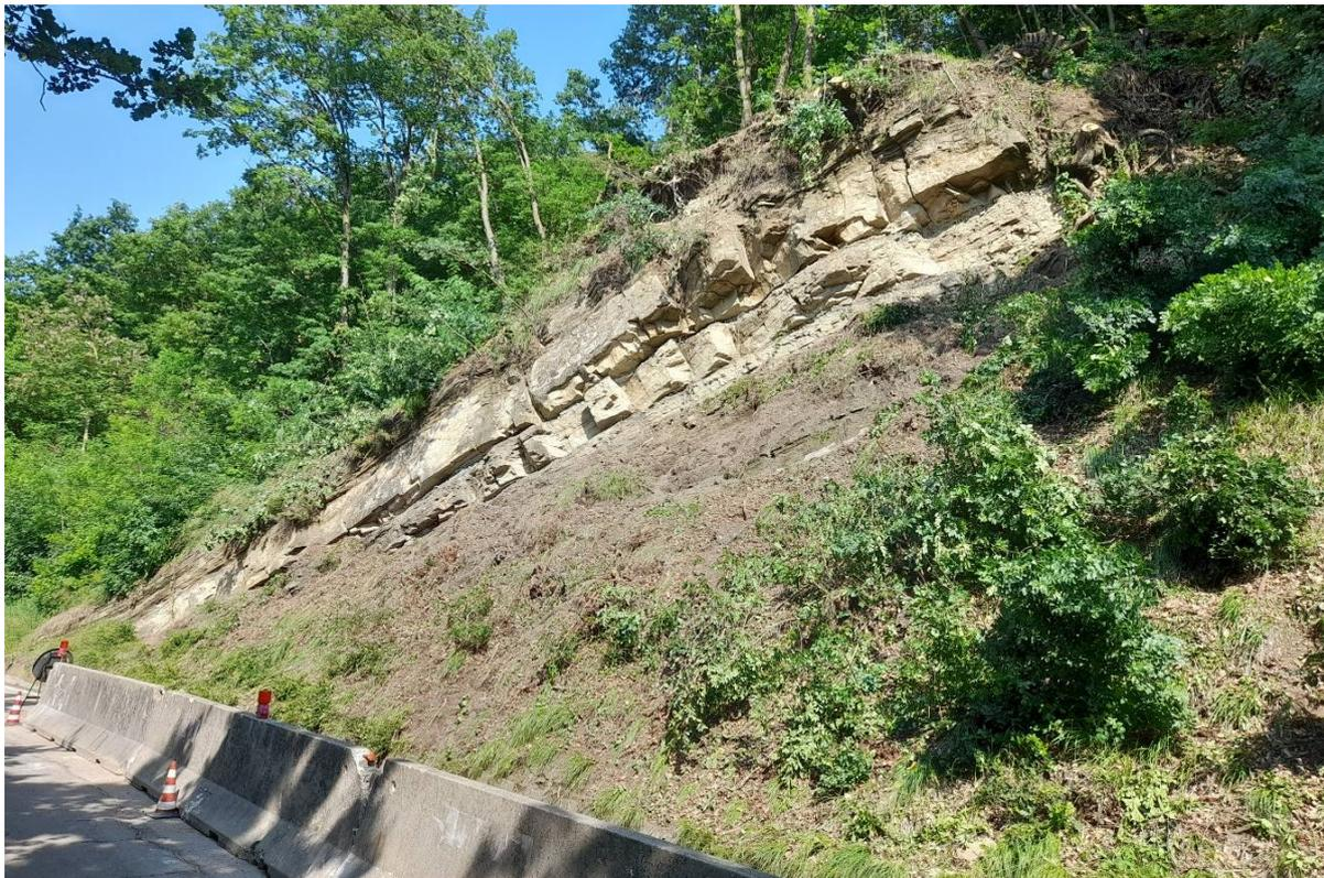
Foto 2 – Vista del versante nel settore occidentale dove verrà eseguito il rinforzo corticale e la chiodatura dei massi più voluminosi (area di intervento 1)
