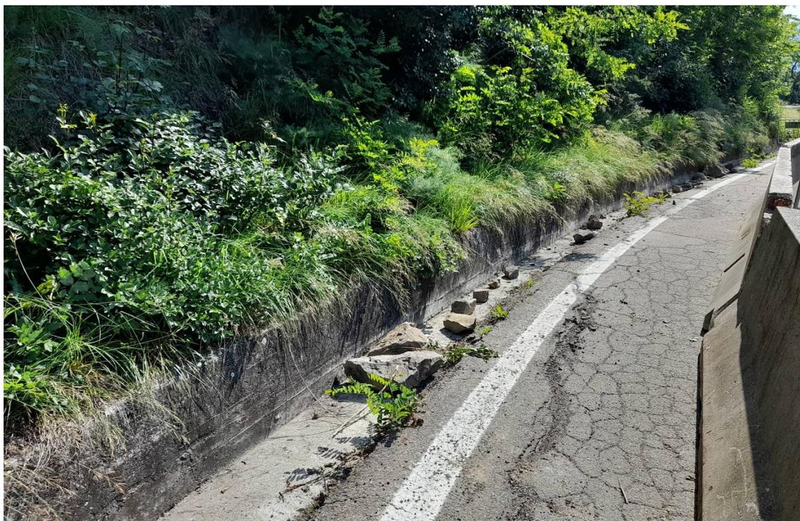
**Foto 3 – Particolare dei massi caduti nel settore orientale dove verrà posata la barriera paramassi (area di intervento 1).**
