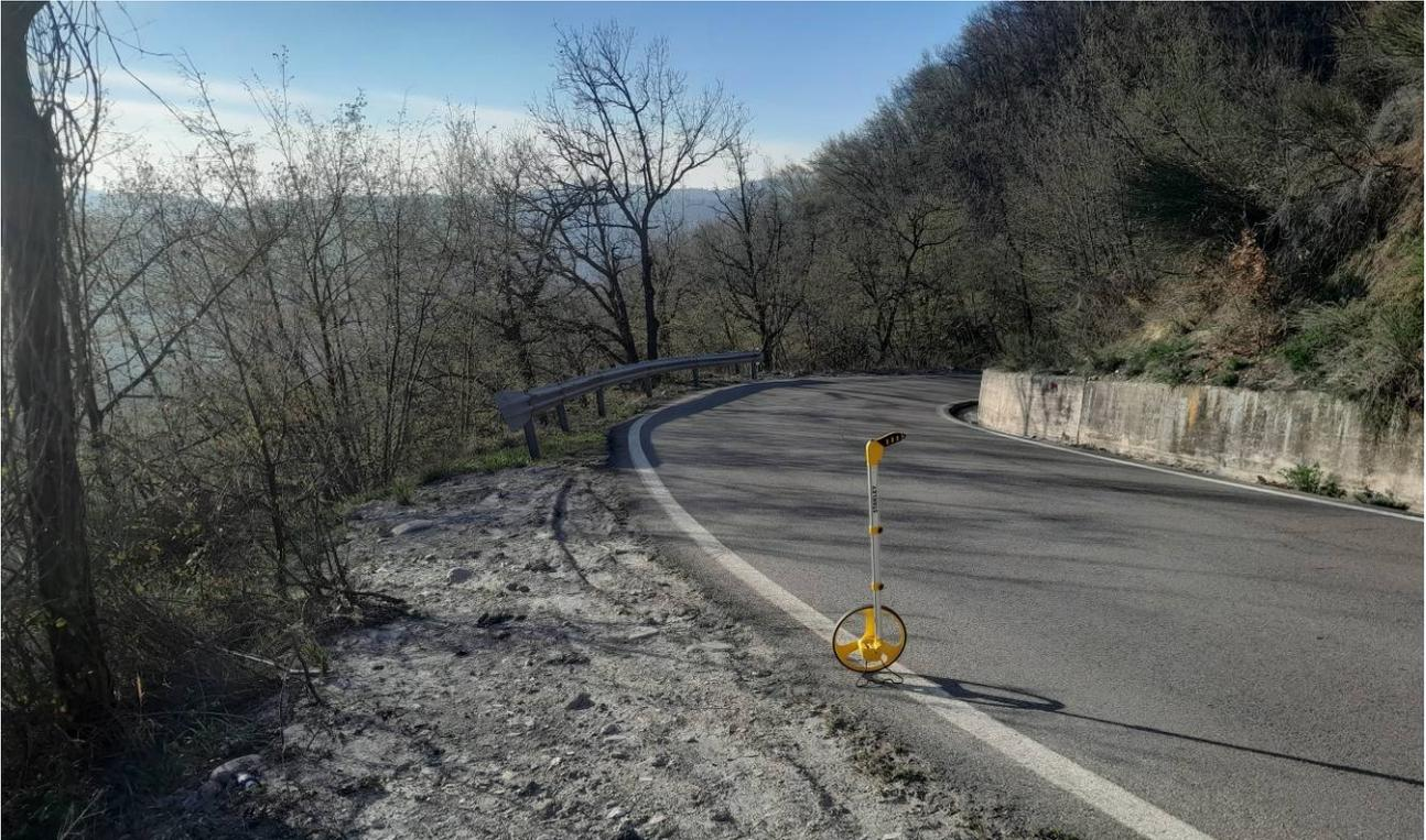
**Fig. 4 – Vista della curva al km 2+350 in cui la pendenza del tratto stradale è dell'ordine del 12%; si nota la carenza dei sistemi di ritenuta e le barriere di sicurezza esistenti non a norma.**
