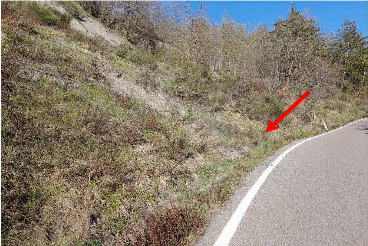
**Fig. 2 – Vista del tratto di strada provinciale in prossimità del km 2+700, dove verrà realizzata l'opera di sostegno in gabbioni lungo la scarpata di monte e l'impermeabilizzazione della cunetta, in corrispondenza dove è avvenuto uno scivolamento del terreno che ha anche occluso la cunetta di monte.**
