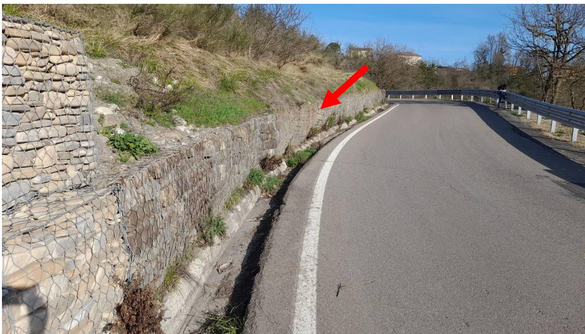
**Fig. 3 – Vista del tratto di strada provinciale al km 2+500, dove verrà ripristinata la gabbionata esistente particolarmente deteriorata (si nota lo “spanciamento” indicato dalla freccia), a proseguimento di quella realizzata nel primo stralcio (in primo piano nella foto).**
