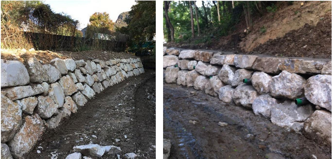
Figura 7 – Esempi di protezioni radenti in massi ciclopici anche con scarico dei tubi dreni in alveo
