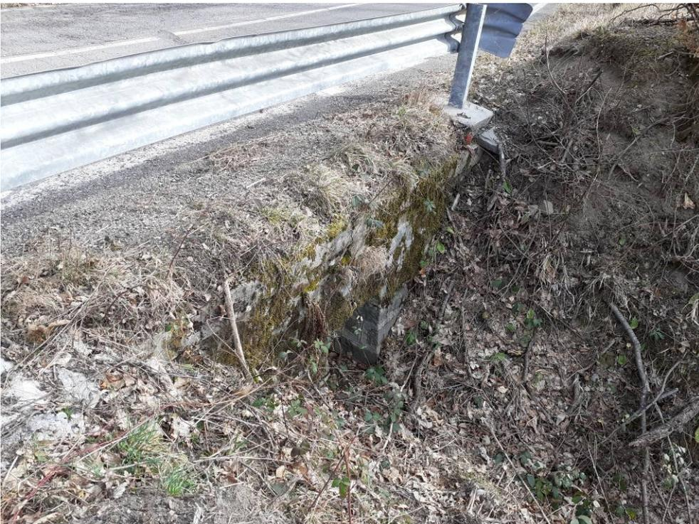
**Foto 11 – Vista del tratto di SP 15 al km 24+400 (secondo muro, erosione del cordolo, ammaloramento della muratura e ostruzione dell'attraversamento idraulico)**
