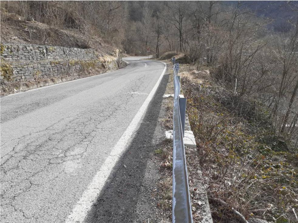
Foto 8 – Vista del tratto di SP 15 al km 24+400 (primo muro, sistemi di ritenuta non a norma)
