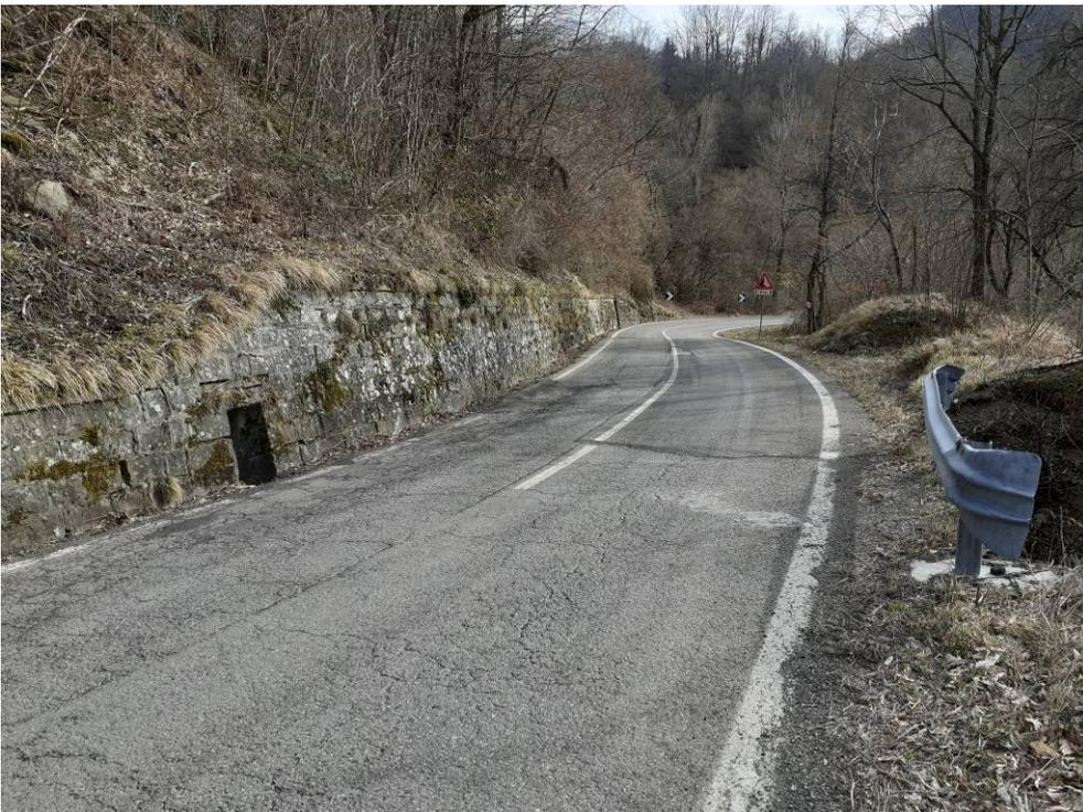
Foto 9 – Vista del tratto di SP 15 al km 24+400 (secondo muro, sistemi di ritenuta non a norma)
