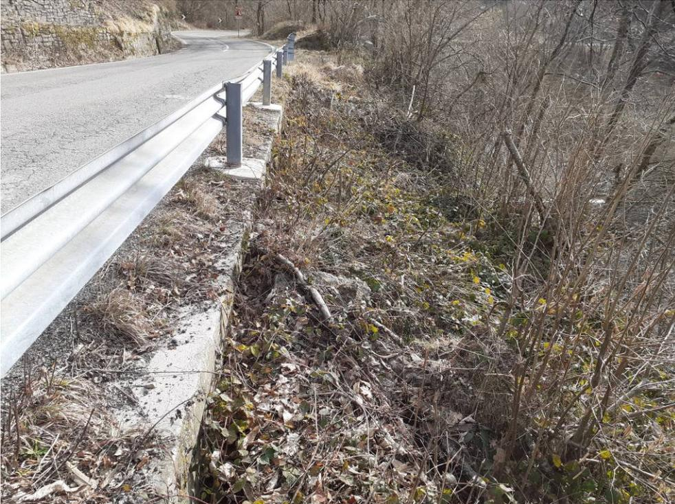
**Foto 10 – Vista del tratto di SP 15 al km 24+400 (primo muro, erosione del cordolo e accumulo di materiale e vegetazione infestante a ridosso della muratura)**
