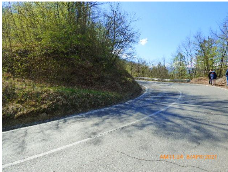
Foto 2 – Curva vista da valle (lato San Polo d'Enza)
