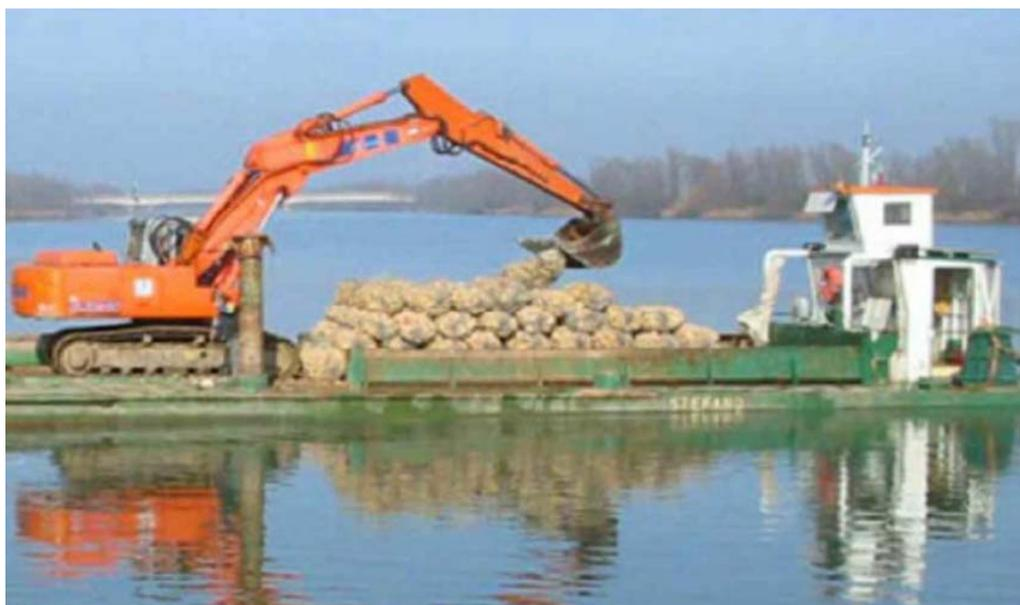
Figura 9.8: esempio di varo delle burghe da pontone
