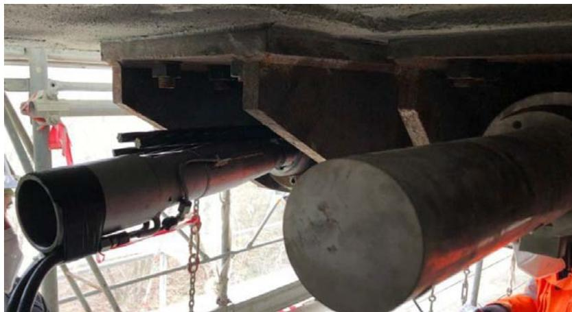
*Figura 9.11: – Cavi di Post Tensione esterna per manutenzione viadotti – tesatura con martinetto monotrefolo*
