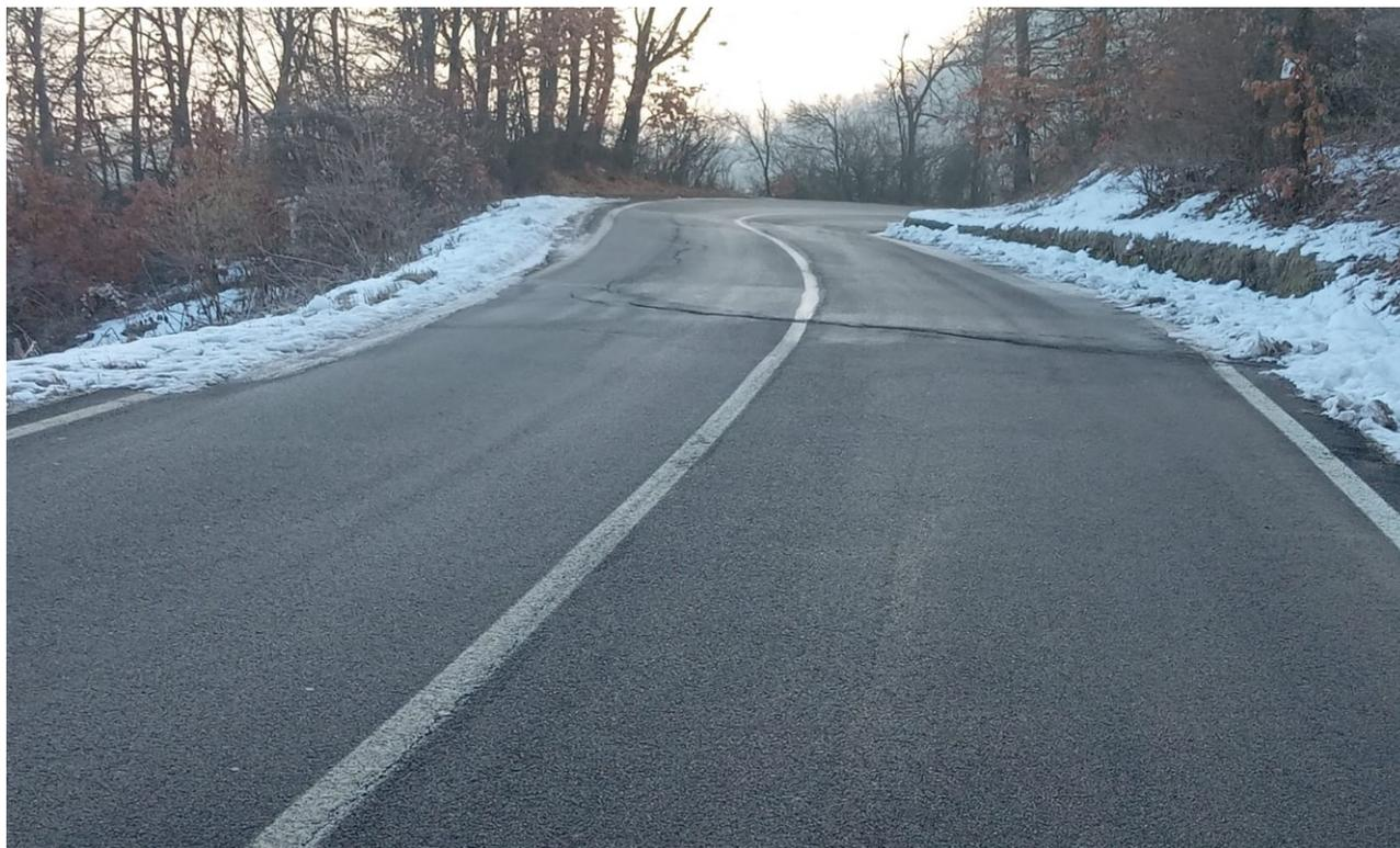
**Foto 1 – Vista del piano viabile della strada provinciale interessato dal movimento franoso, particolare del cedimento sul lato orientale.**
