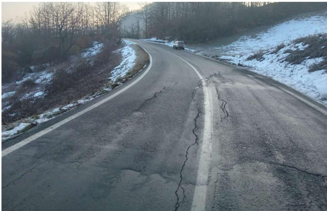
**Foto 2 – Vista da Ovest del piano viabile, si notano le fessure di trazione causate dal movimento franoso.**
