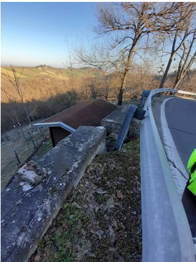
Foto 5 e Foto 6 - Viste del distacco tra le porzioni di cordolo
