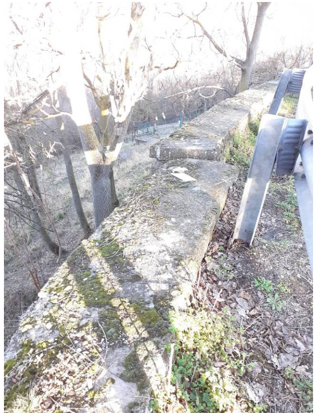
Foto 3 e Foto 4 – Viste del distacco delle porzioni di cordolo
