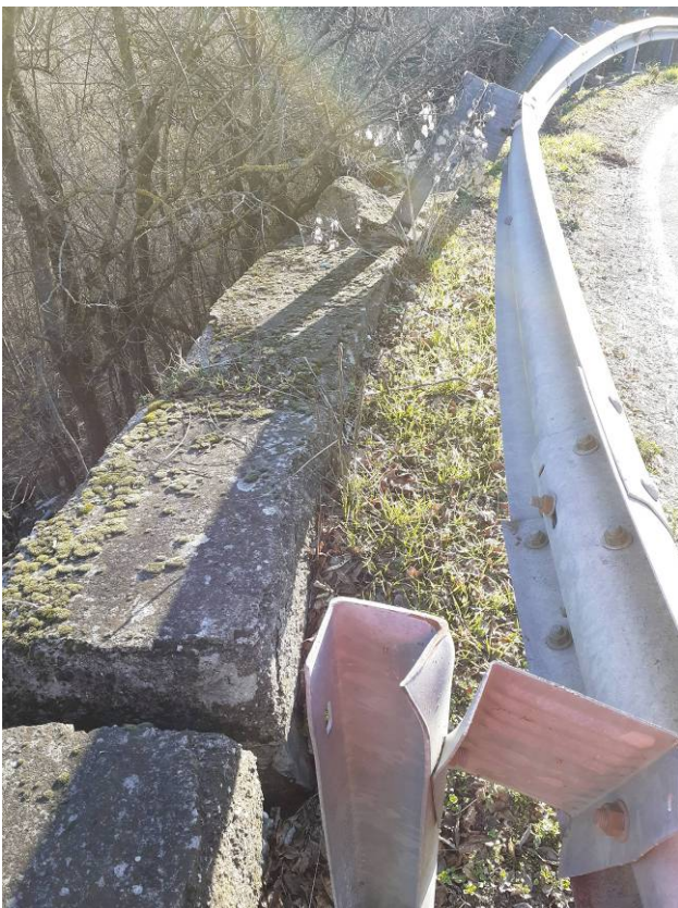
Foto 9 e Foto 10 - Viste del distacco tra le porzioni di cordolo
