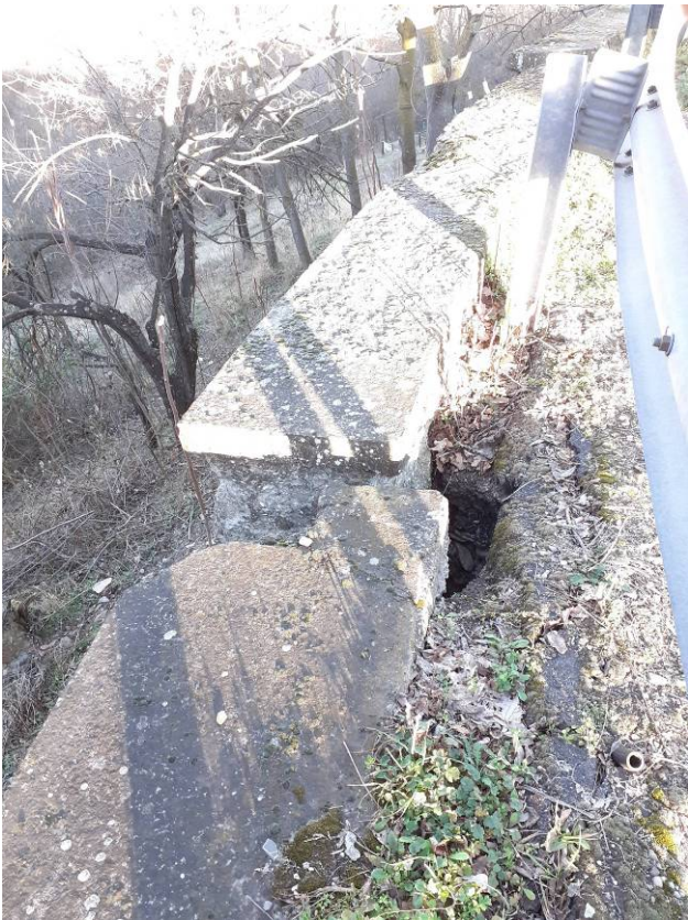
Foto 3 e Foto 4 – Viste del distacco delle porzioni di cordolo
