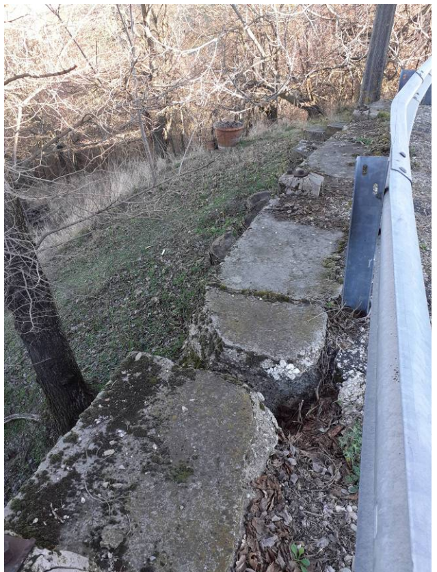
Foto 3 e Foto 4 – Viste del distacco delle porzioni di cordolo
