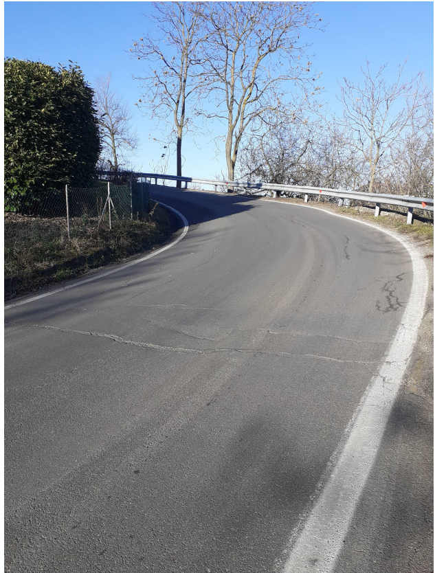
Foto 11 e Foto 12 – Viste del cordolo e delle fessurazioni del manto stradale
