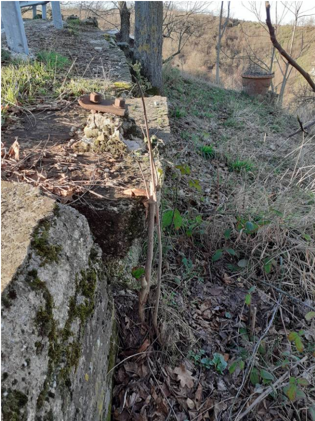
Foto 7 e Foto 8 – Viste del ribaltamento del muro
