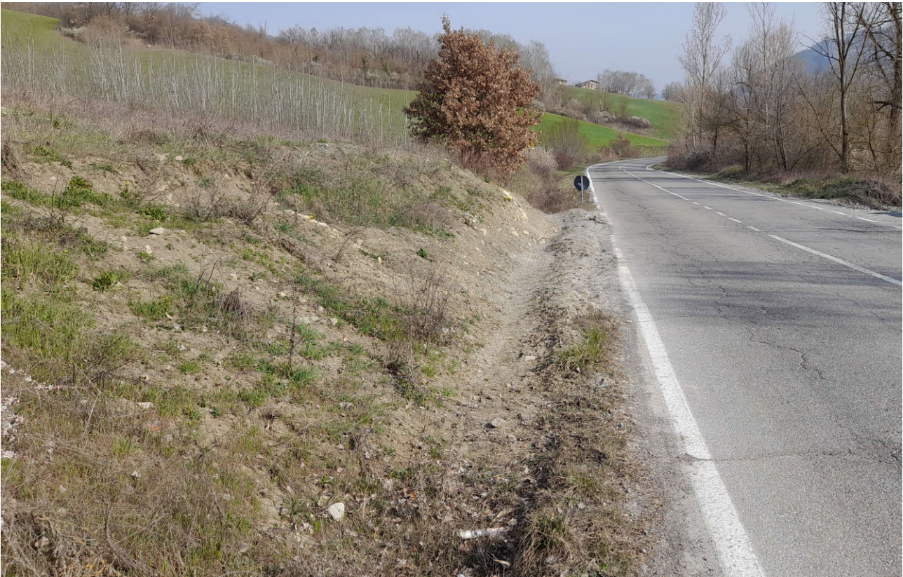
Foto 6 – Vista del piede della scarpata.
