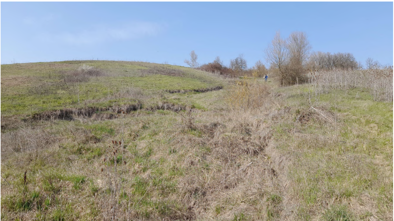
Foto 2 – Vista del versante in dissesto.
