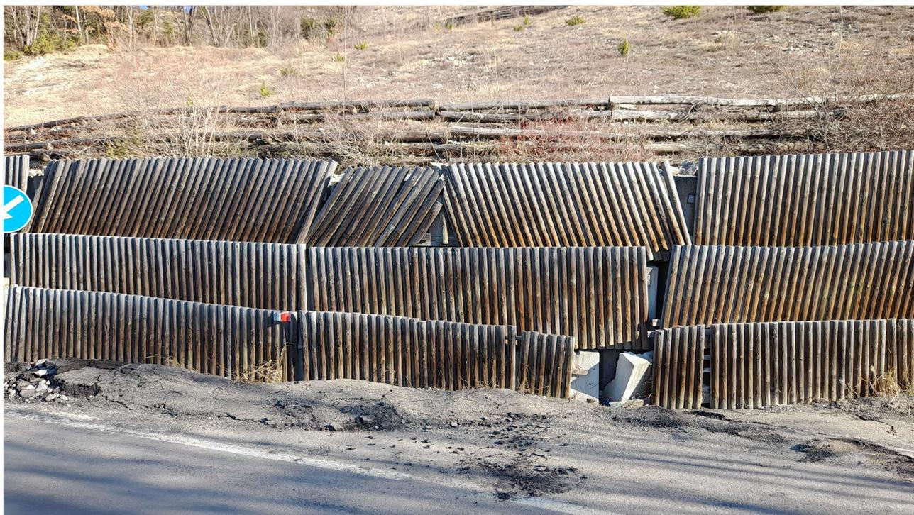
**Figura 2 – Vista frontale dell’opera di sostegno della frana, si notano le deformazioni del piano viabile causate dallo spostamento dell’opera di sostegno. (Foto da SP 15)**
