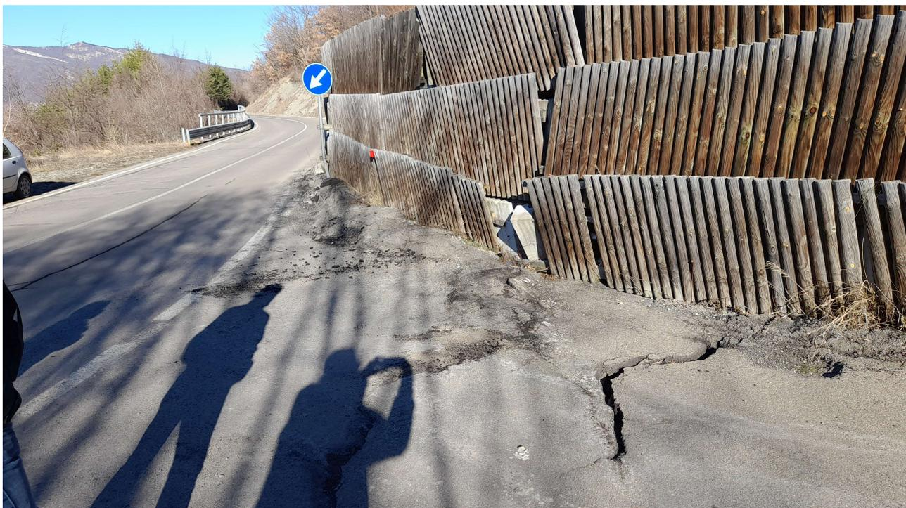
**Figura 3 – Vista dell’opera di sostegno della frana da sud, si notano anche da questa angolazione le deformazioni del piano viabile causate dallo spostamento dell’opera di sostegno. (foto da SP 15)**
