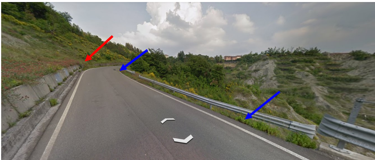
Fig. 2 – Vista del tratto di strada provinciale dal km 2+480 al km 2+545, dove verranno realizzate le opere di sostegno della scarpata di valle (frecce blu) e il ripristino della gabbionata a sostegno della scarpata di monte (freccia rossa).
