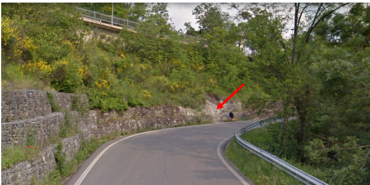
Fig. 3 – Vista del tratto di strada provinciale al km 2+700, dove verrà ripristinata la gabbionata esistente attualmente deteriorata (indicata dalla freccia), nella parte alta si nota sede stradale della sovrastante SP 7.
