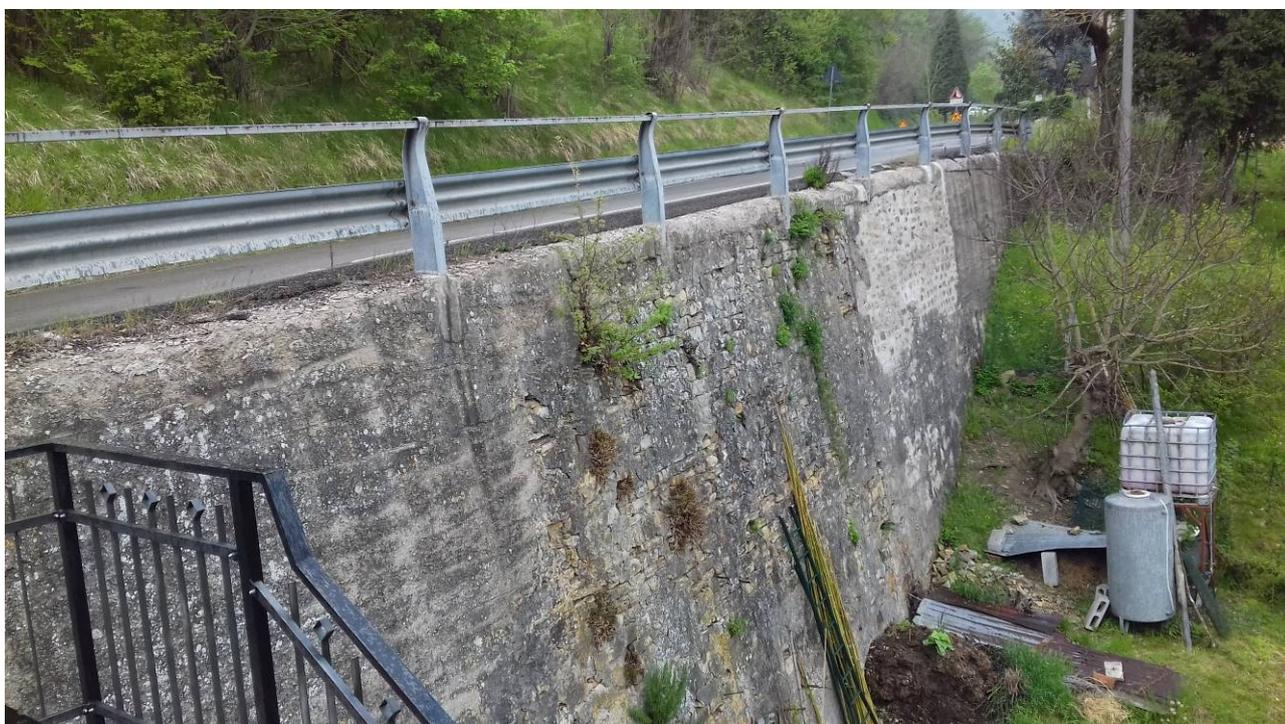
Fig. 3 – Particolare del muro di controscarpa, in cui si notano parti ammalorate della muratura in sasso.
