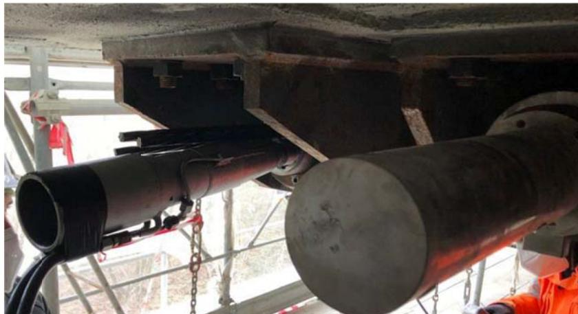
Figura 9.5: – Cavi di Post Tensione esterna per manutenzione viadotti – tesatura con martinetto monotrefolo
