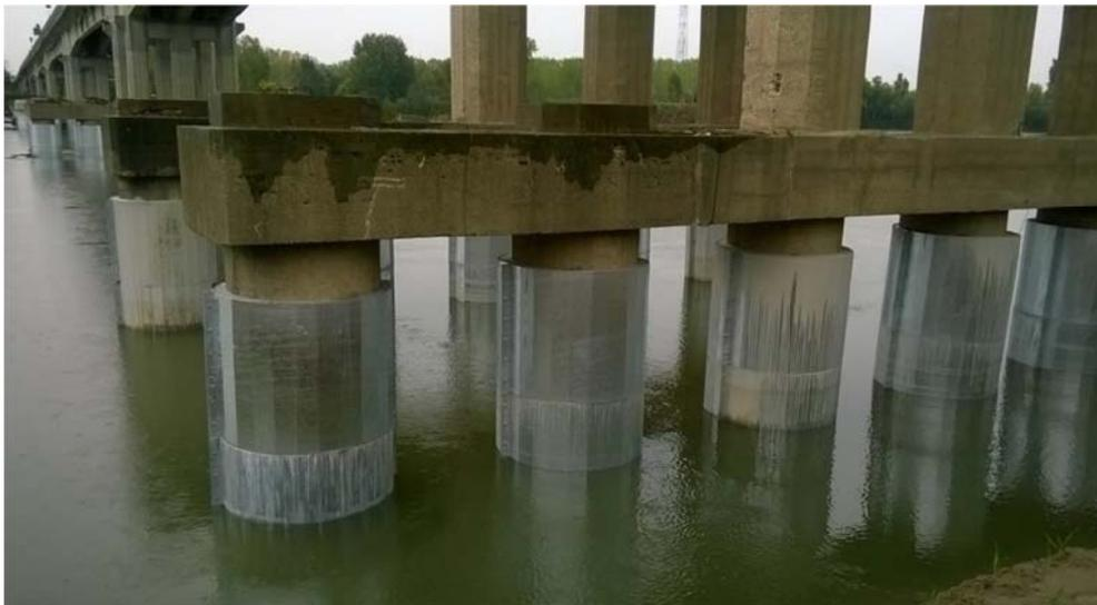
*Figura 9.3: esempio di intervento di imcamiciatura eseguito presso il ponte di Boretto (2017)*
