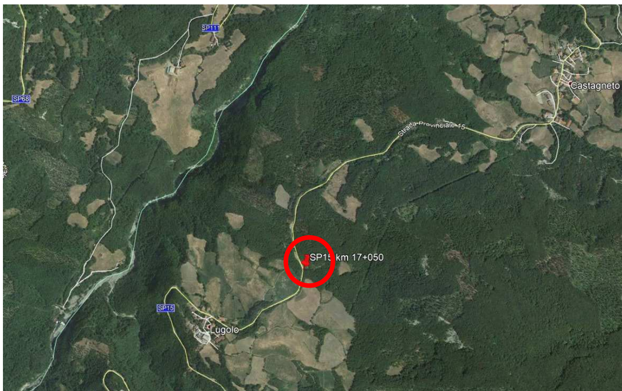
Fig. 1 – Vista aerea dell'area oggetto di intervento.
