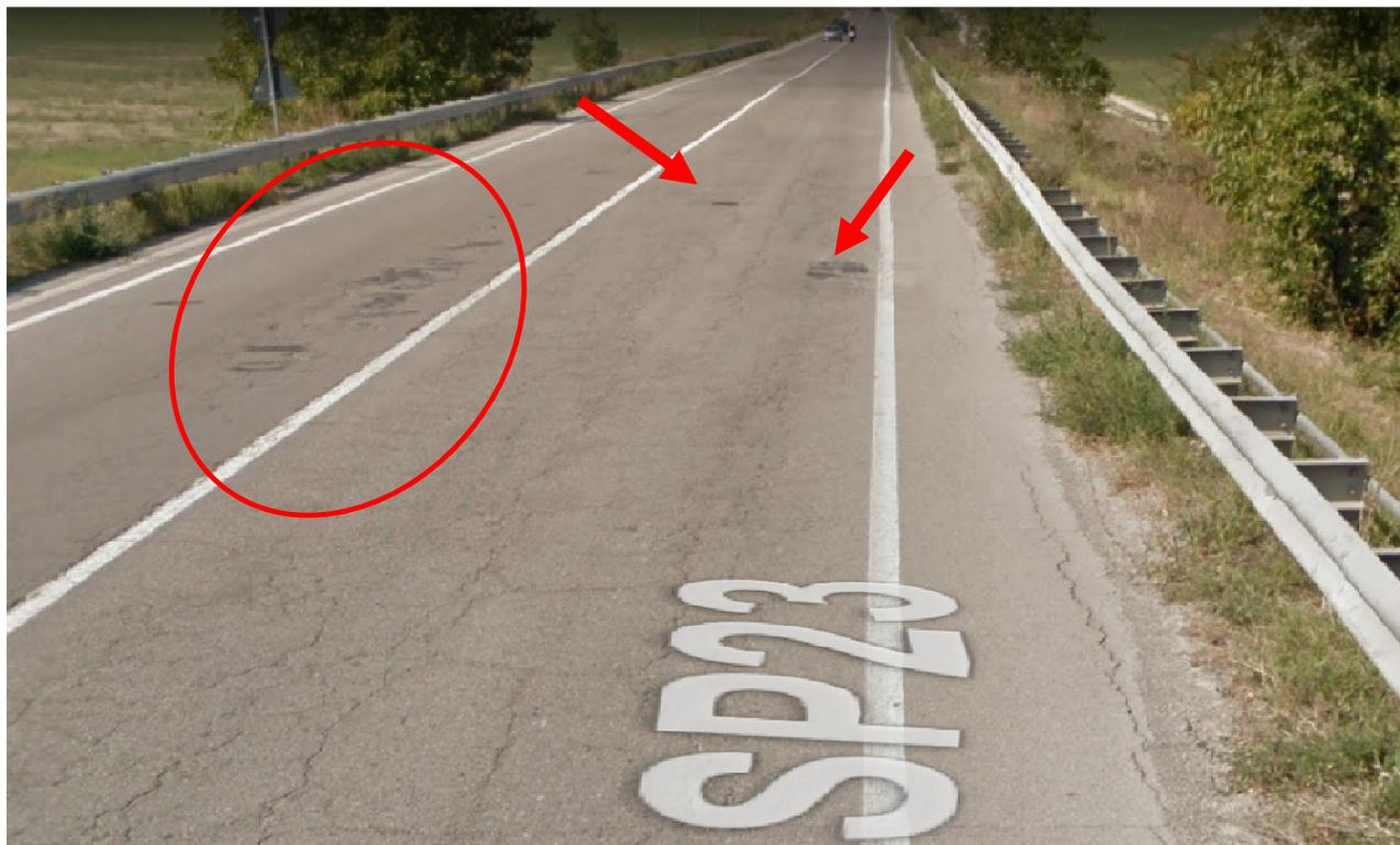
Foto 1 – Vista dei dissesti della pavimentazione presenti sul tratto oggetto di intervento dalla SP 23, con fessurazioni a blocchi e a ragnatela e con distacco di strati superficiali di conglomerato bituminoso.
