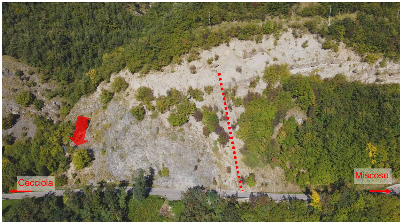
Foto 1 – Vista del versante a monte della SP 15 dal km 23+800 al km 24+080, con indicata la posizione della barriera paramassi installata nel 2016 e la traiettoria dei massi caduti nell’agosto 2025.
