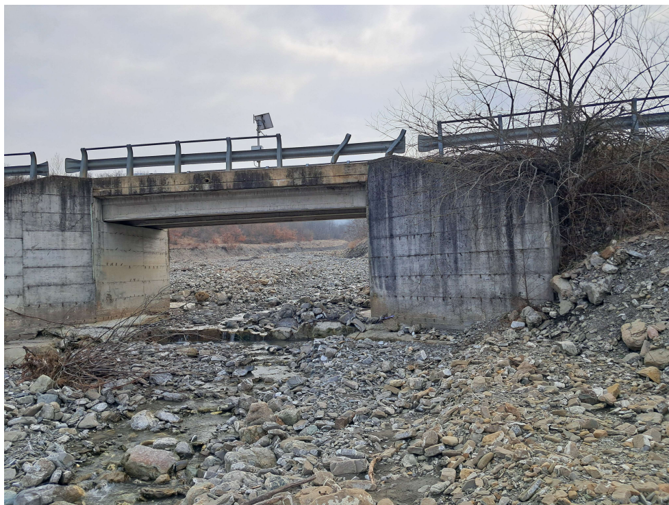
Figura 4 – Foto da valle del manufatto della SP 57 per l’attraversamento del torrente Vaina
