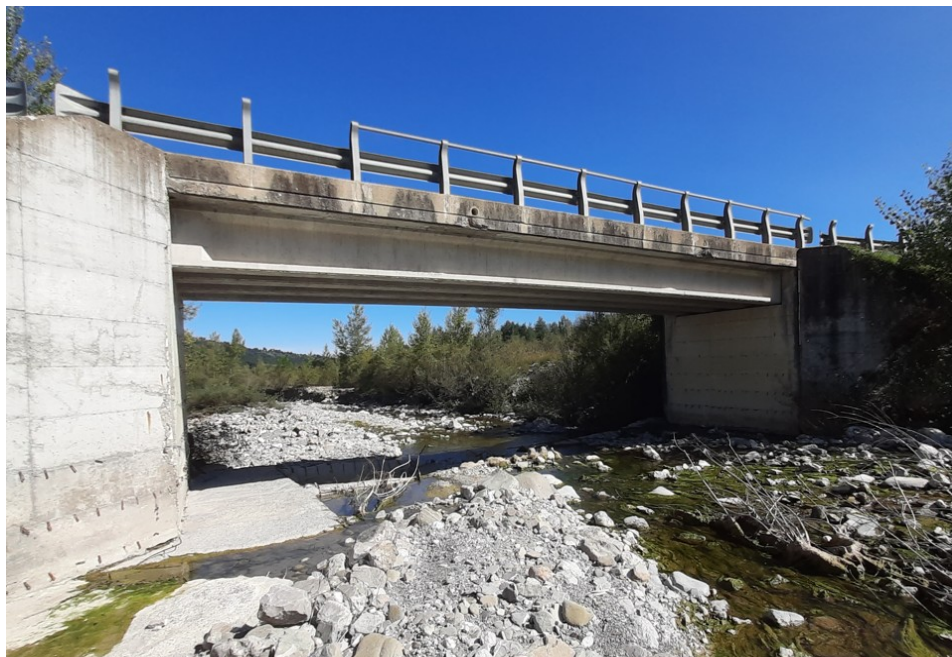
Fig. 3 – Foto da monte del manufatto della SP 57 per l'attraversamento del torrente Lonza
