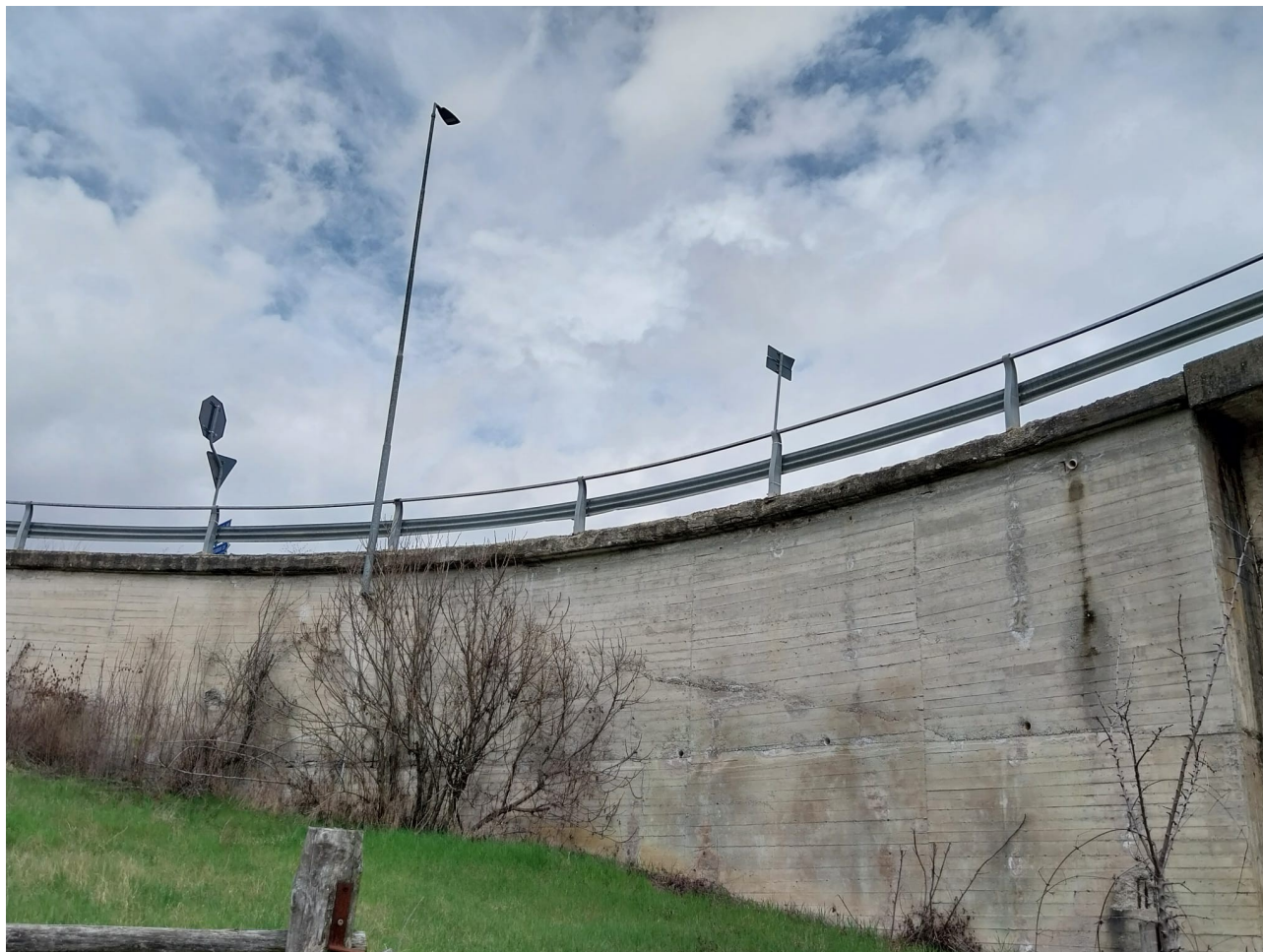
Figura 10 Vista cordolo svincolo SP9
