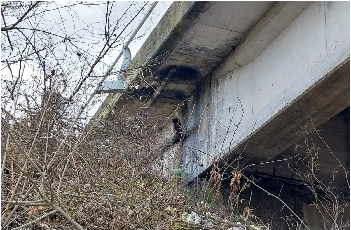
Figura 8- Vista muro spalla di appoggio est
