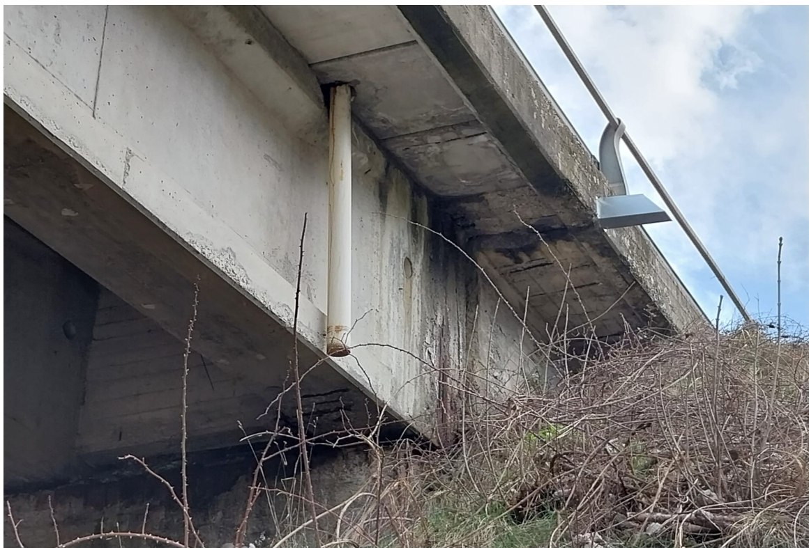
Figura 9- Vista muro spalla di appoggio est
