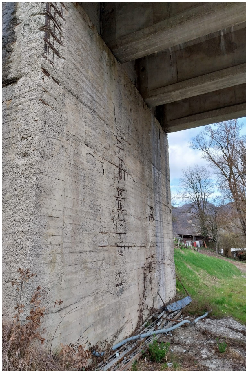
Figura 5- Vista muro spalla di appoggio ovest
