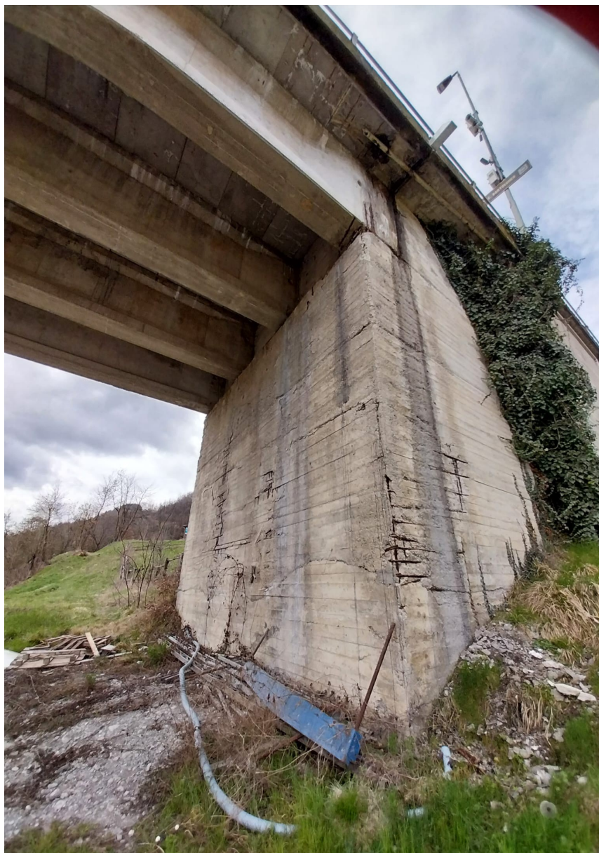
Figura 6- Vista muro spalla di appoggio ovest
