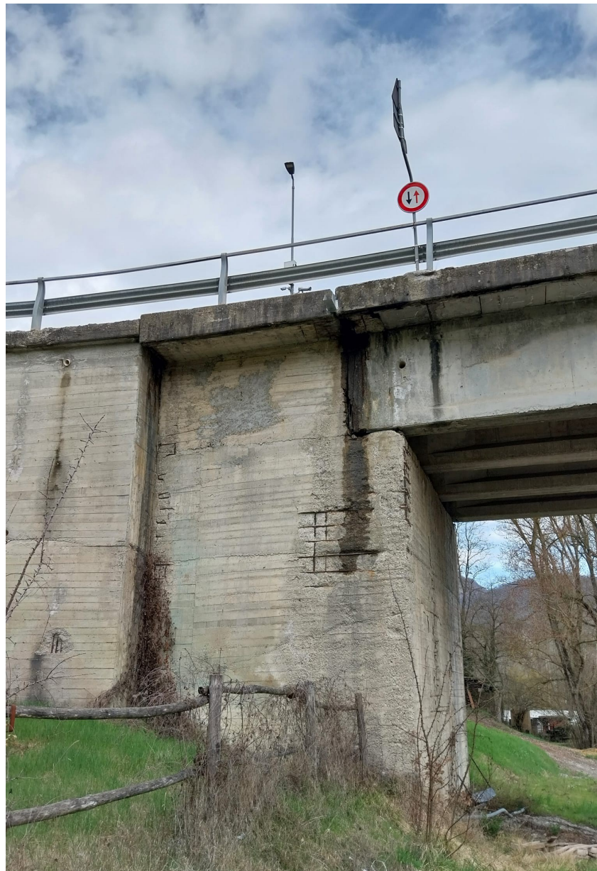
Figura 4- Vista spalla di appoggio ovest
