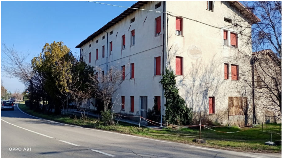
FOTO 1 via vittorio Emanuele II direzione nord lato dell'intervento
