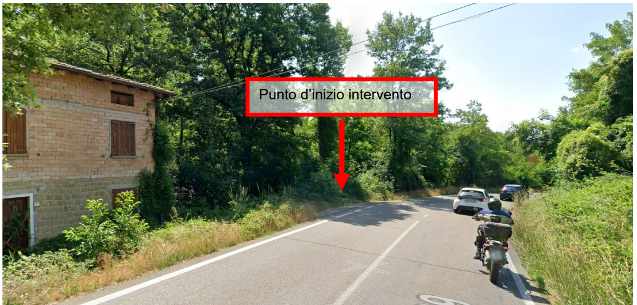
Foto 6-Individuazione della zona di Inizio Intervento dell'opera di sostegno su pali
