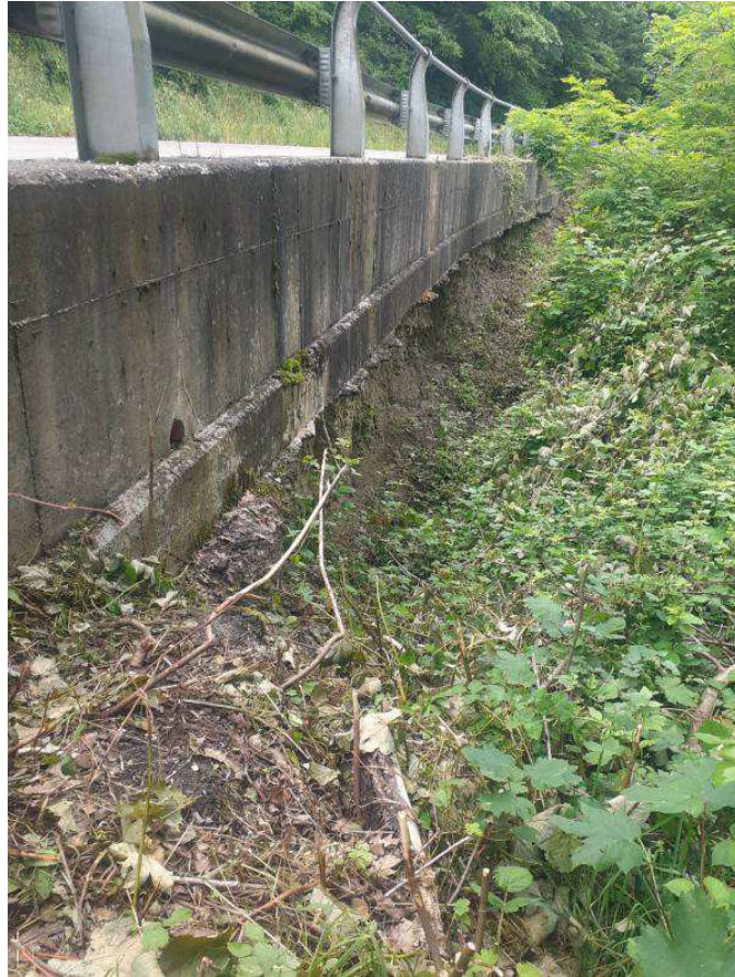
Foto 5 - Muro esistente su pali al quale ci si andrà a connettere
