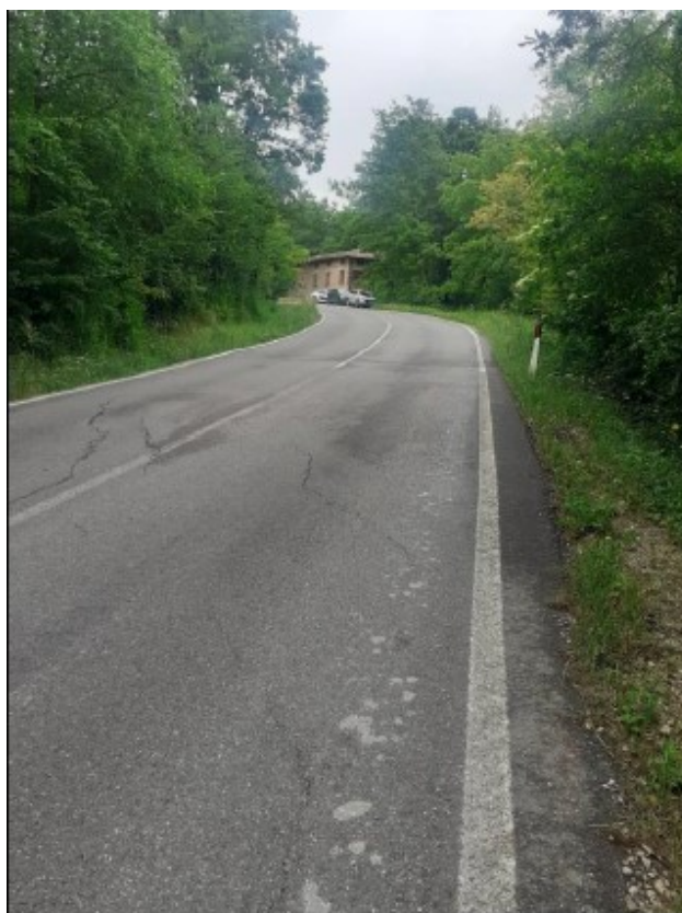
Foto 1 – Vista del tratto stradale oggetto d'intervento verso Felina
