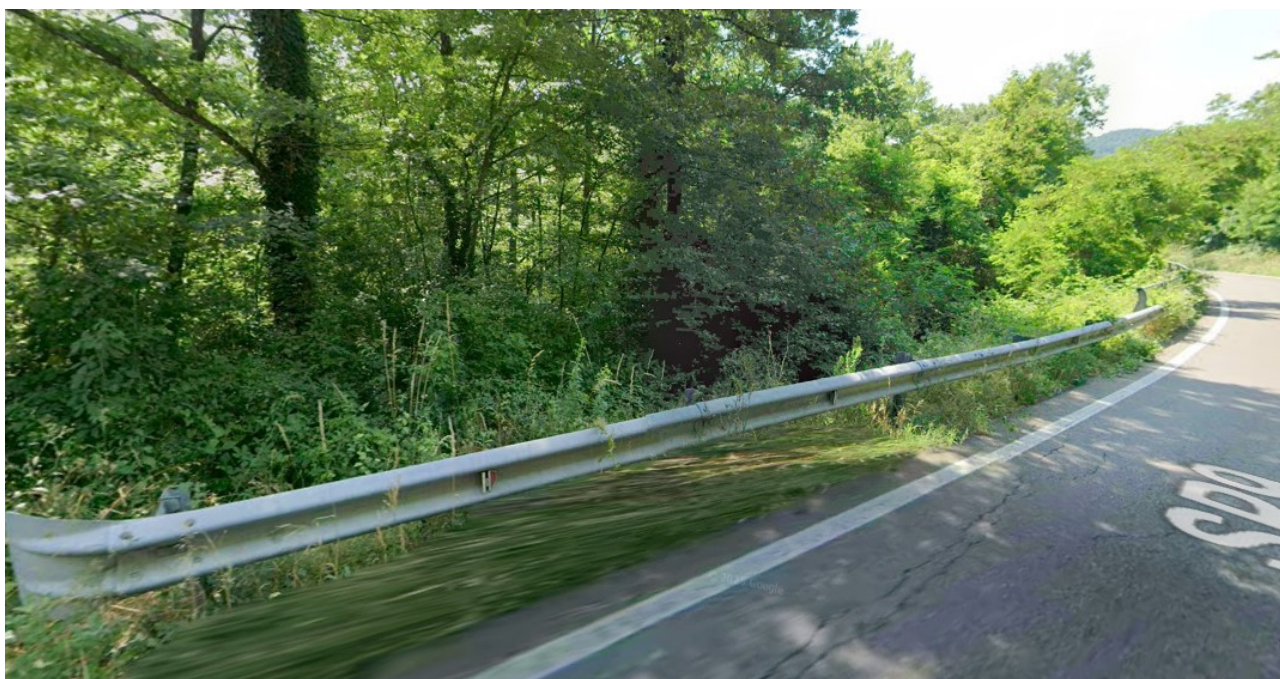
Foto 3 e 4 – Barriera Bordo laterale che verrà sostituita con nuova barriera bordo ponte su cordolo in c.a di nuova realizzazione
