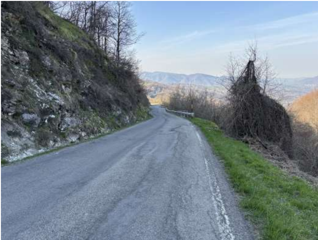
Foto 1 – Vista della porzione oggetto di rettifica e sostituzione barriera.
