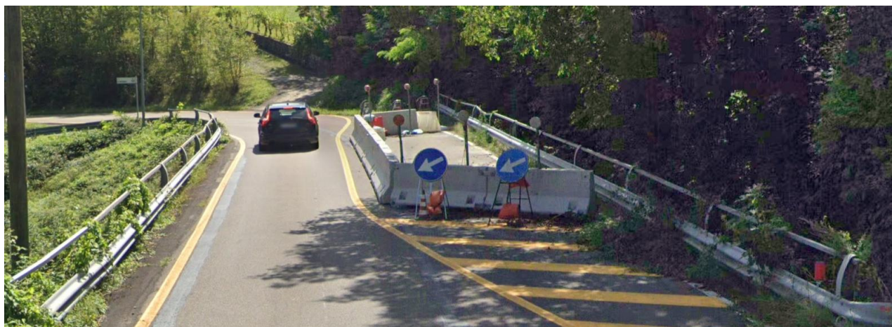
Figura 5 - Vista area di intervento
