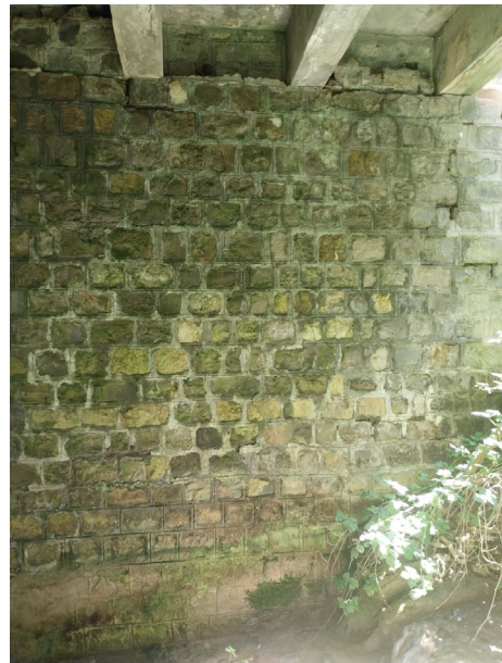
Lesioni spalla destra muratura in pietrame
