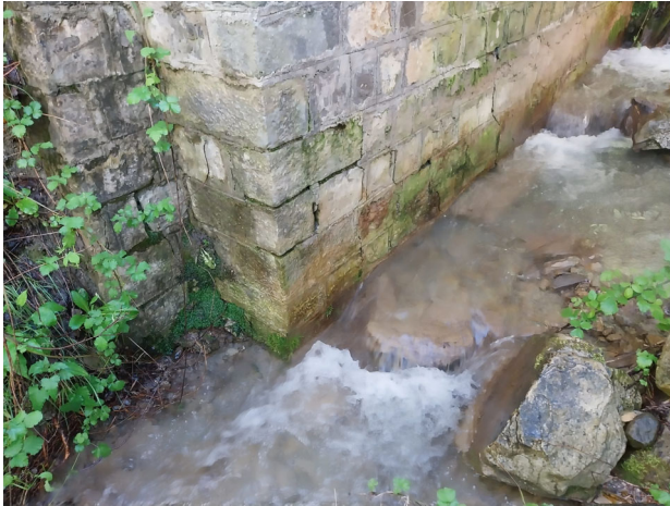
Lesioni spalla destra muratura in pietrame
