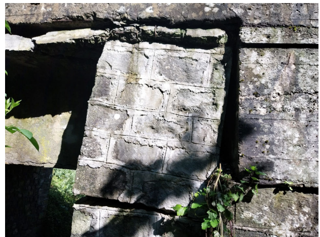
Lesioni spalla destra di monte appoggio impalcato
