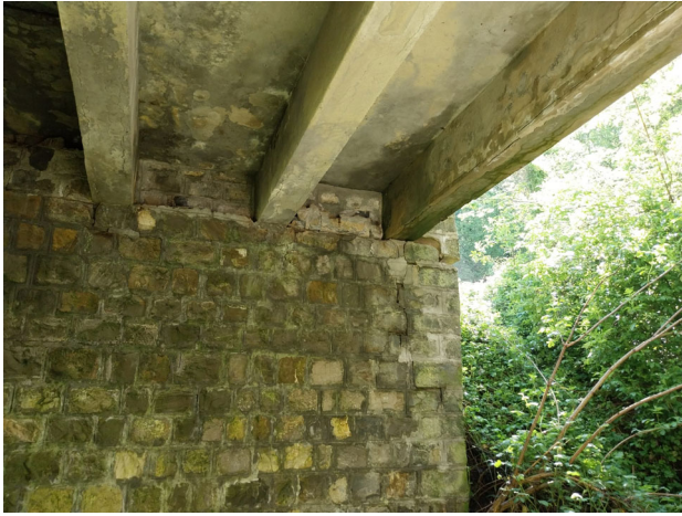
Lesioni spalla destra di monte e appoggio impalcato spalla destra di valle
