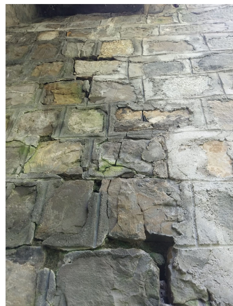
Lesioni spalla destra muratura in pietrame
