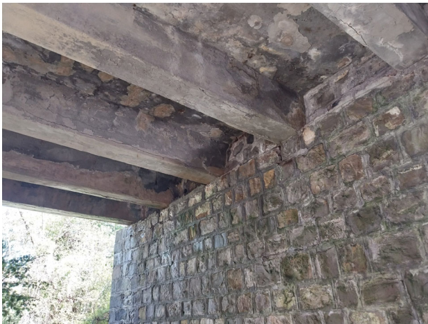
Degrado trave maestre e della soletta dell'impalcato
