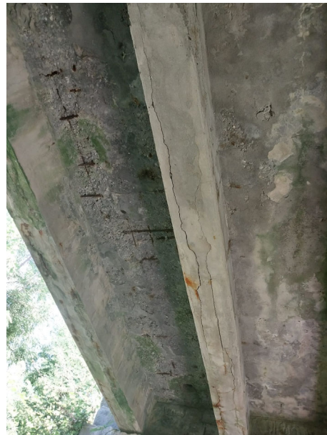
Degrado trave maestre e della soletta dell'impalcato
