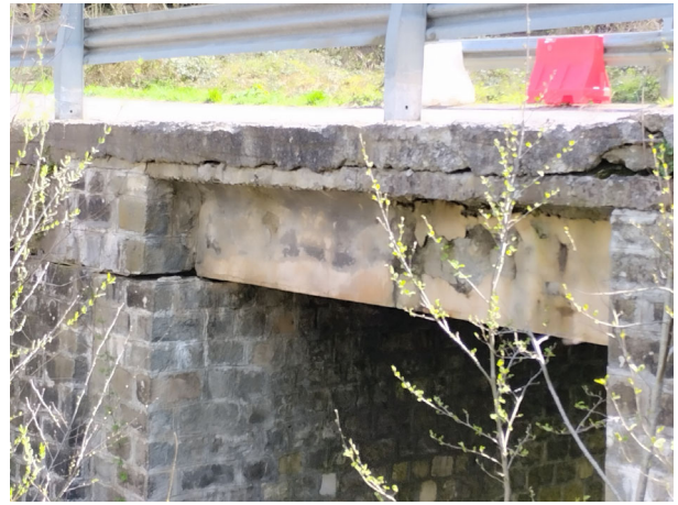
Lesioni spalla destra di monte e appoggio impalcato spalla destra di valle
