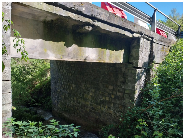
Lesioni spalla destra di monte appoggio impalcato
