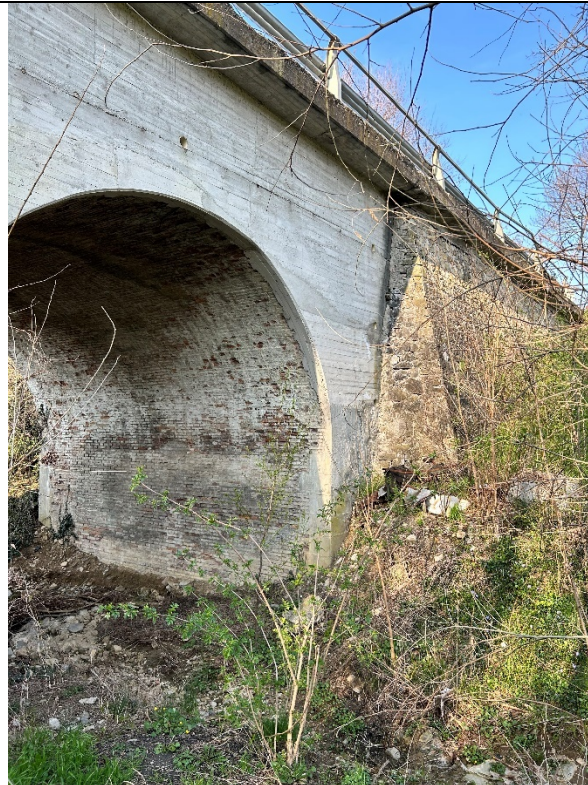
Vista da Sud (Monte) con placcaggio in cls
