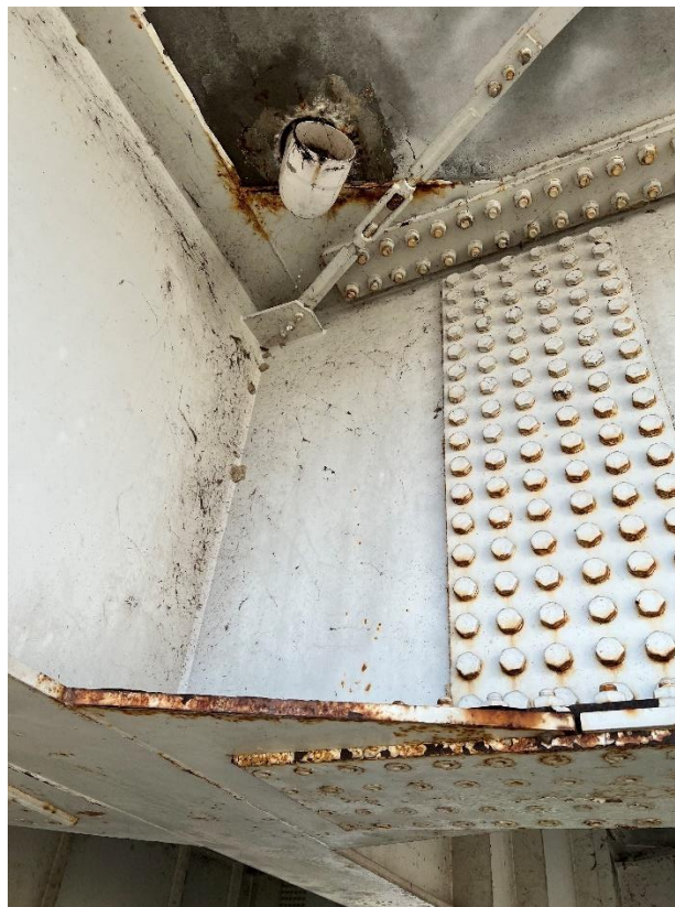
Foto 5 dettaglio giunto e scarico acque impalcato
