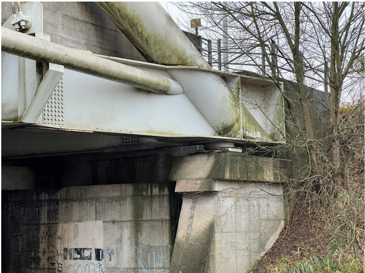
Foto 7 – nodo arco catena e appoggio – vista lato valle dalla sponda idraulica sx
