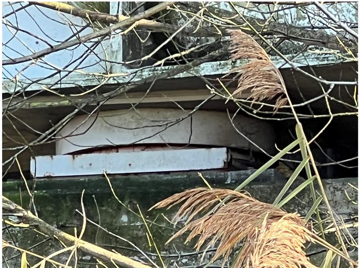
Foto 9 – Apparecchio di appoggio spalla sx lato valle
