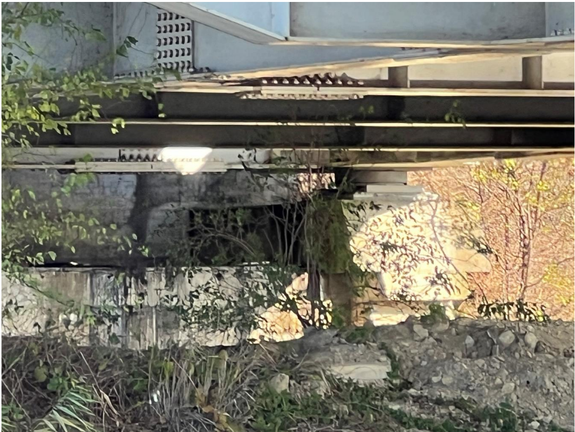
Foto 8 spalla dx e appoggio lato monte
