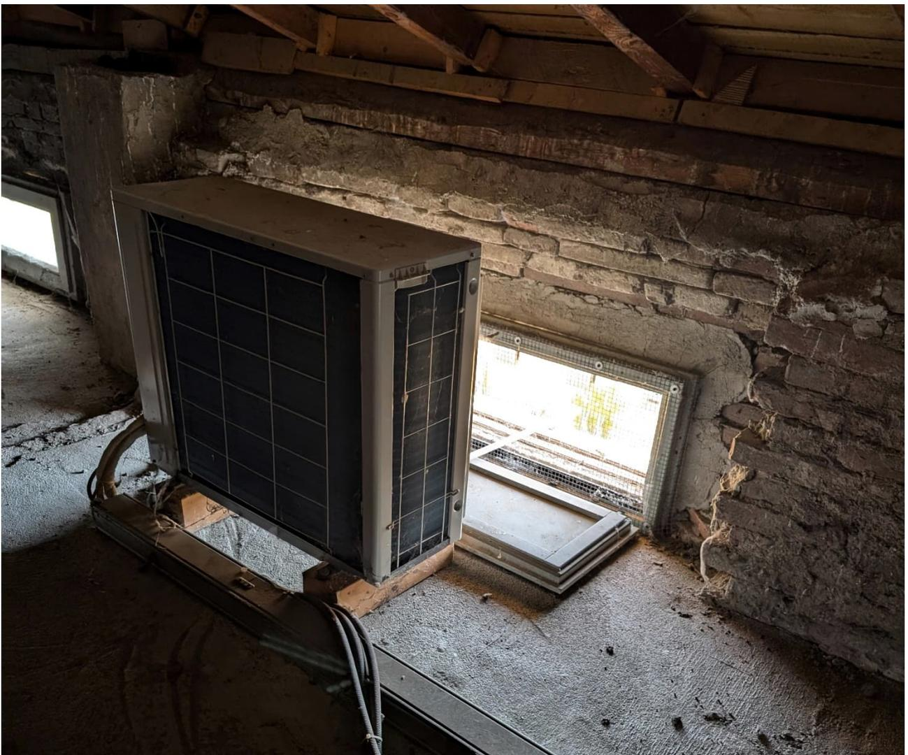
*Pompa di calore esistente con apertura protetta da una rete*
