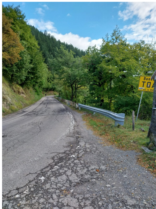
Foto 5 – Porzione della sede stradale oggetto d'intervento.
