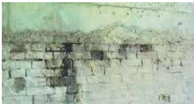
In seguito a un'attenta ispezione visiva delle pile, come si evince dalle foto riportate precedentemente, si può constatare un avanzato stato di degrado della muratura in corrispondenza delle pile.
