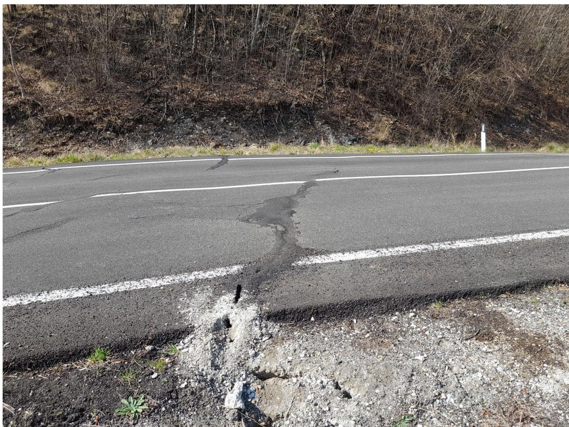
Foto 1,2 – Vista dei dissesti della pavimentazione presenti sul tratto oggetto di intervento dalla SP 9, con fessurazioni a blocchi e a ragnatela e con distacco di strati superficiale di conglomerato bituminoso.
