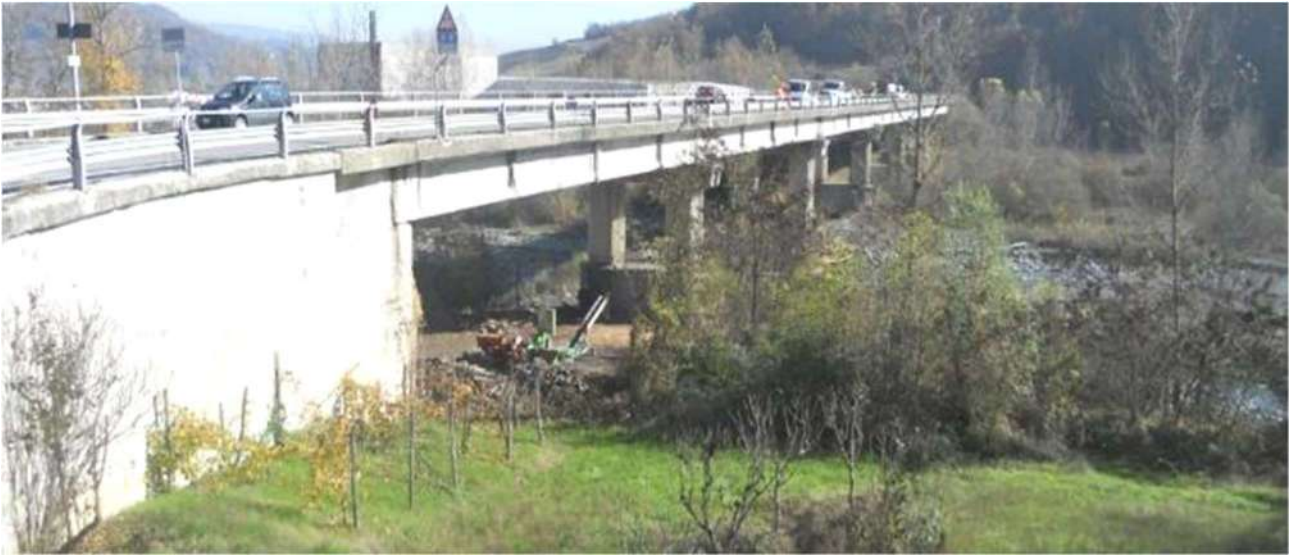
Figura 4 - Vista laterale sud
