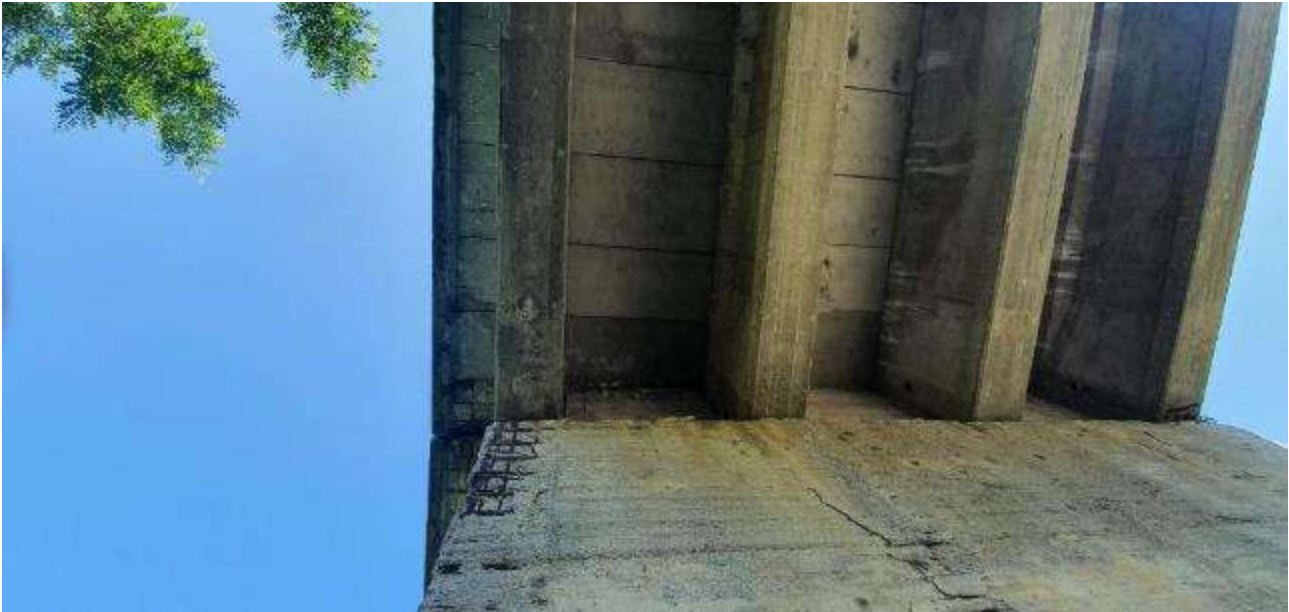
Figura 6 - Vista muro spalla di appoggio ovest
