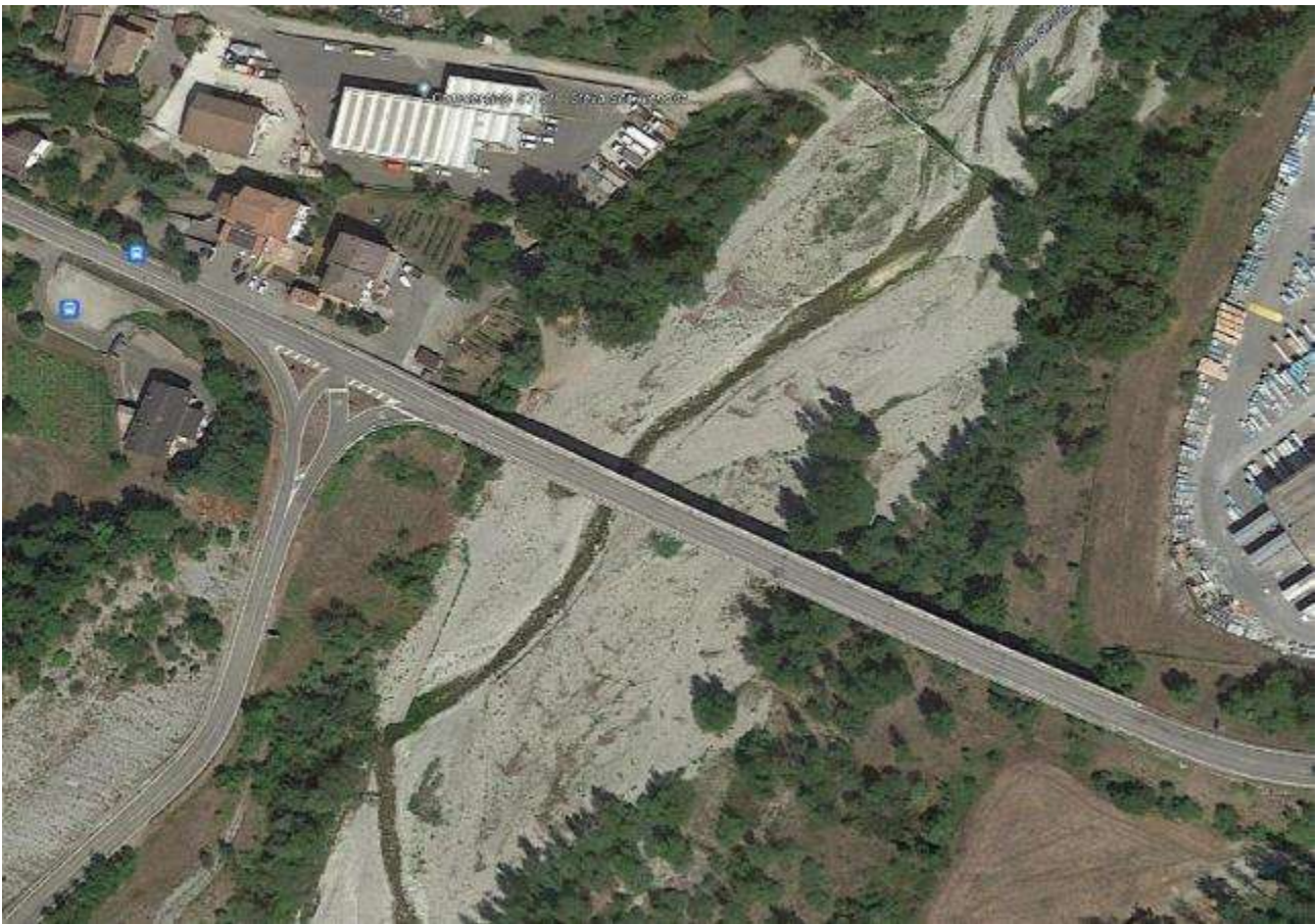
Figura 2 - Localizzazione ponte sul torrente Secchiello in comune di Villa Minozzo
