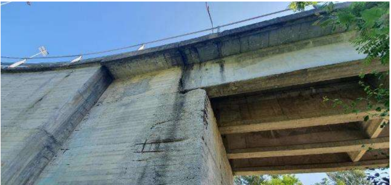
Figura 5 - Vista spalla di appoggio ovest
