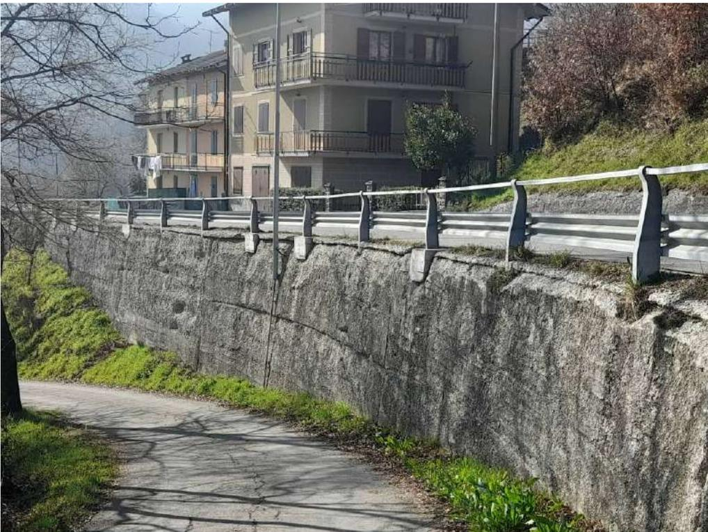
Foto 8 - vista dell'erosione superficiale del muro B e del cordolo sommitale, dei pali di pubblica illuminazione
