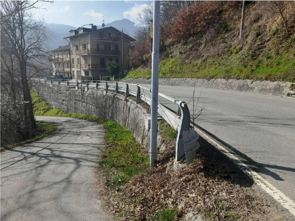
Foto 7 - vista della barriera stradale su muro B, del degrado del muro e del cordolo sommitale, dei pali di pubblica illuminazione
