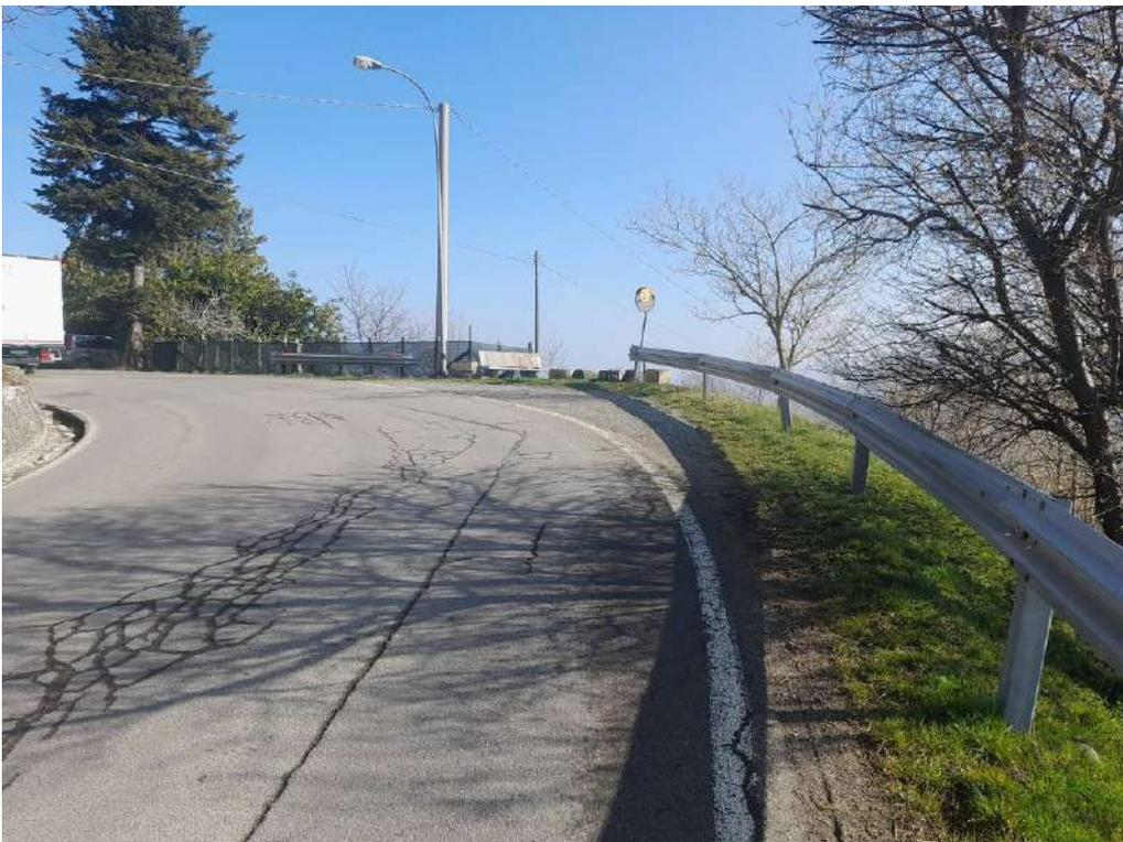
Foto 2 - vista del tratto stradale oggetto di intervento, dei degradi della pavimentazione stradale e dei sistemi di ritenuta discontinui esistenti
