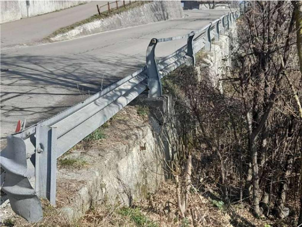
Foto 9 - vista della barriera stradale su muro A, del degrado del muro e del cordolo sommitale
