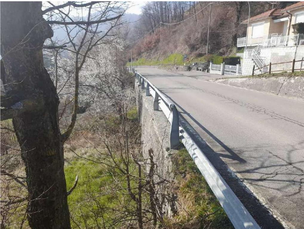
Foto 10 - vista della barriera stradale su muro A, del degrado del cordolo e della pavimentazione stradale
