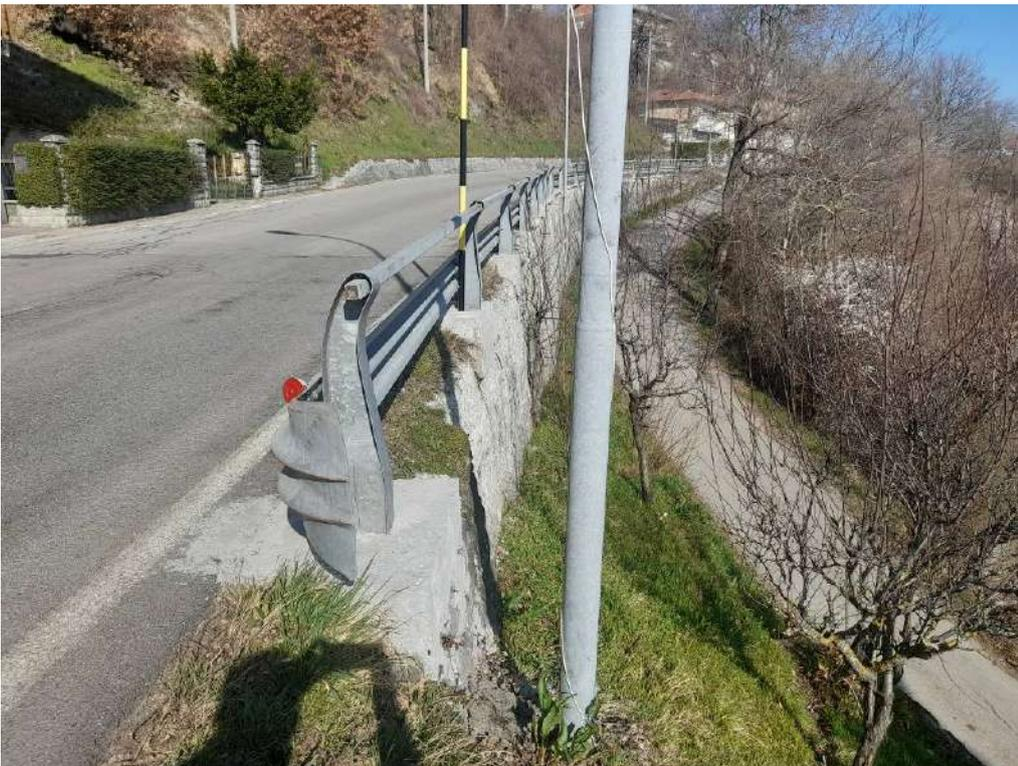
Foto 6 - vista della barriera stradale su muro B, del degrado del muro e del cordolo sommitale, dei pali di pubblica illuminazione
