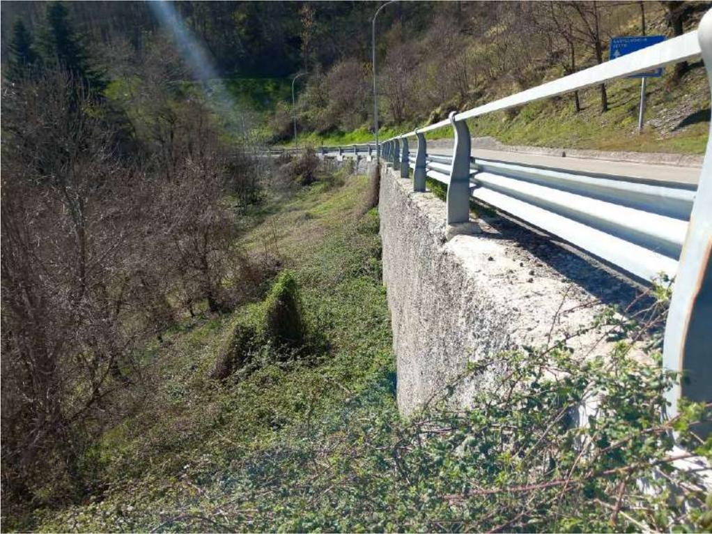
Foto 3 - vista della barriera stradale su muro C, del degrado del muro e del cordolo sommitale, dei pali di pubblica illuminazione
